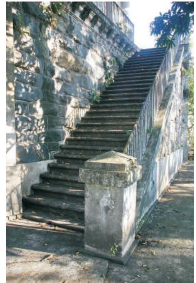
Escada do reservatório. 08/2006.
