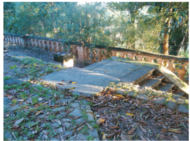
Escada e muro no terreno. 07/2013.
