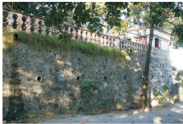
Muro de arrimo, 08/2006.
