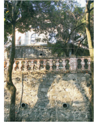
Muro de arrimo. 08/2006.
