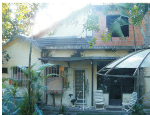
Antiga residência do funcionário alterada. 06/2013.
