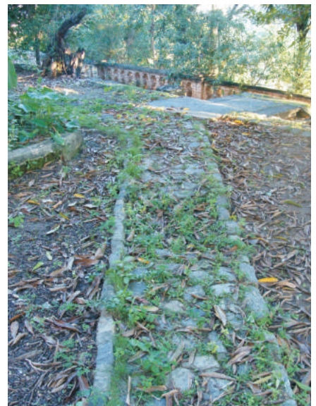
Caminho de pedras no jardim. 07/2013.
