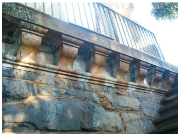
Mísulas do patamar do reservatório. 07/ 2013
