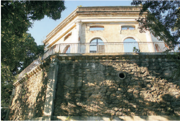
Reservatório, vista externa. 08/2006.
