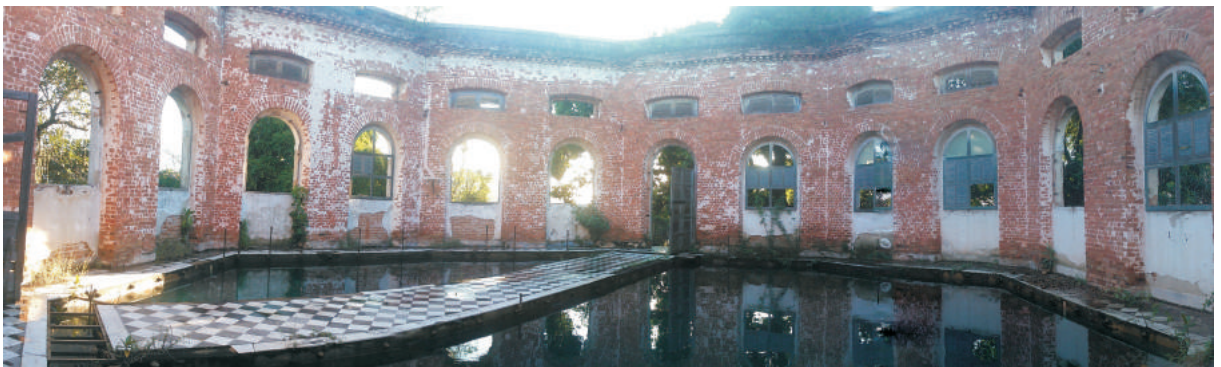
Reservatório. 07/2013 - foto Roberto Anderson Magalhães.
