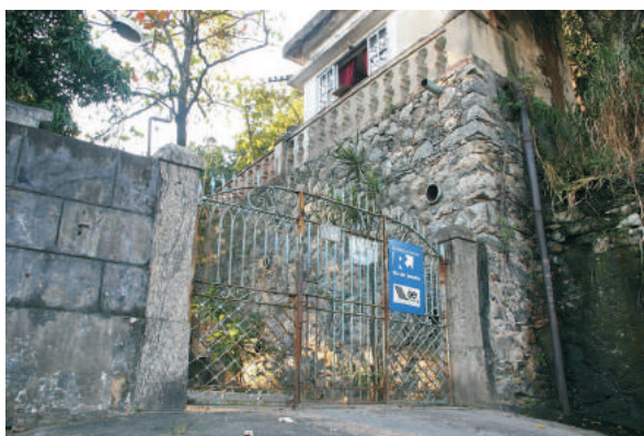
Portão de entrada, 08/2006.
