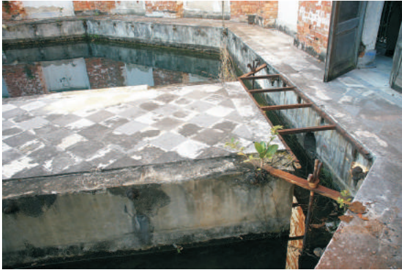
Interior do reservatório. 08/2006.
