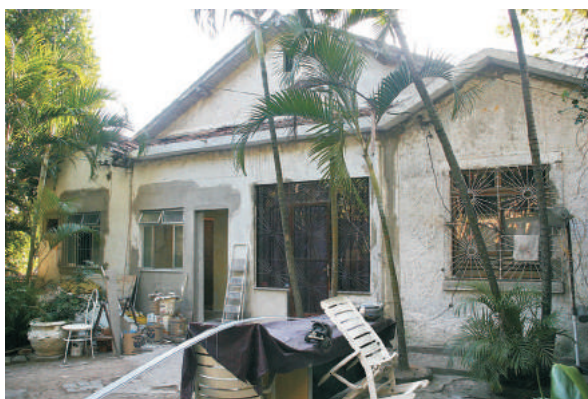
Antiga residência do funcionário em reforma. 08/2006.
