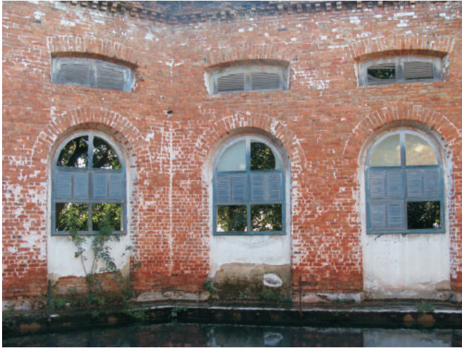
Esquadrias remanescentes do reservatório. 07/2013.
