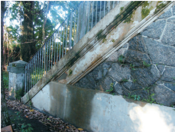
Escada de acesso ao reservatório. 07/2013.
