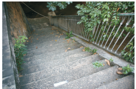
Escada de acesso ao reservatório. 08/2006.
