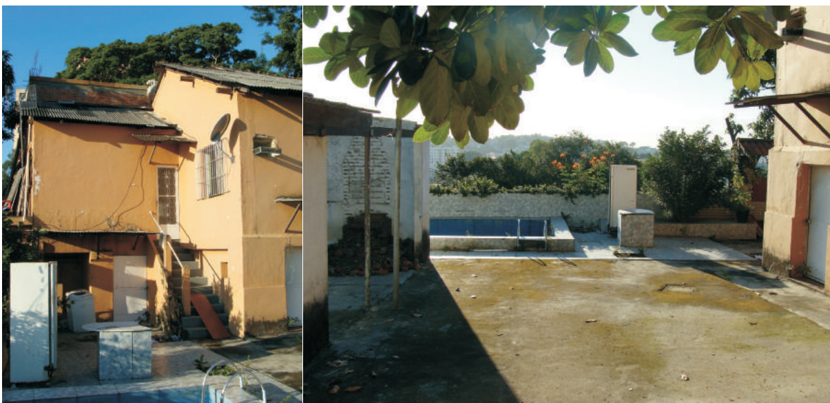
Fundos da casa do antigo encarregado e piscina construída no terreno. 07/2013.
