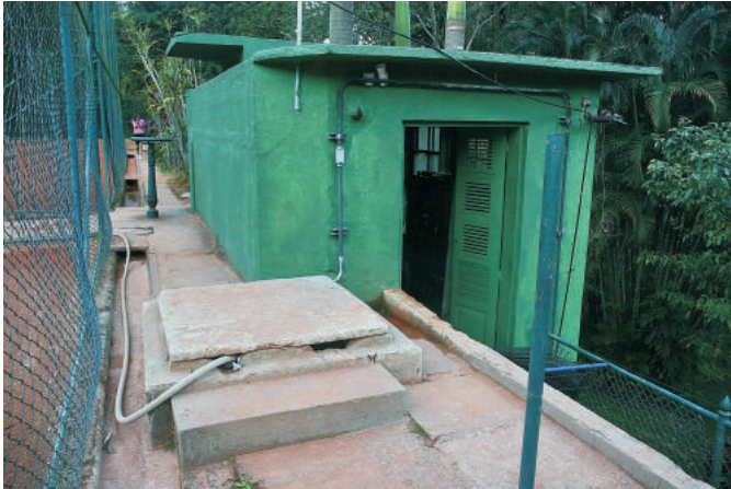
Instalações do reservatório. 08/2008
