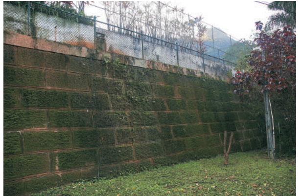
Muro do reservatório. 08/2008
