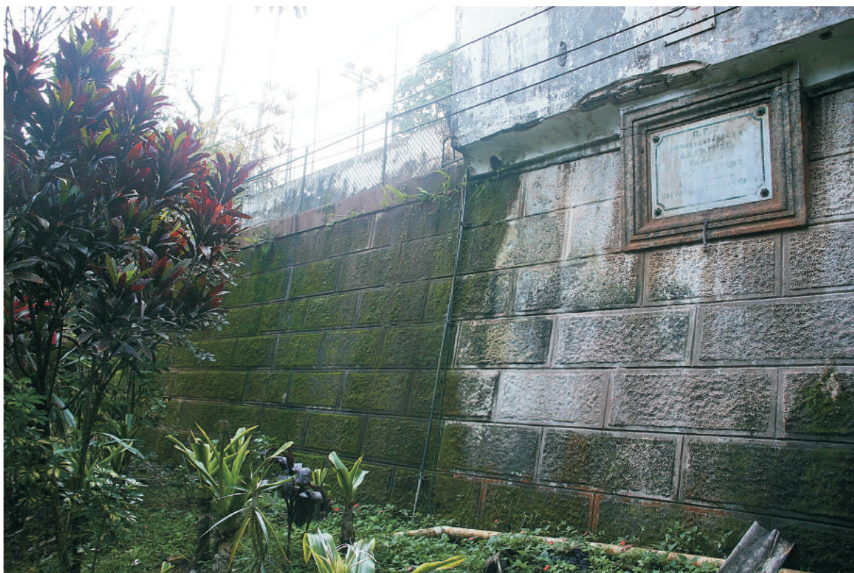
Reservatório dos Macacos, 08/2006.
