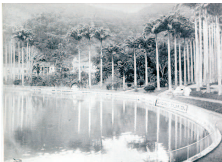
Reservatório ainda descoberto.
