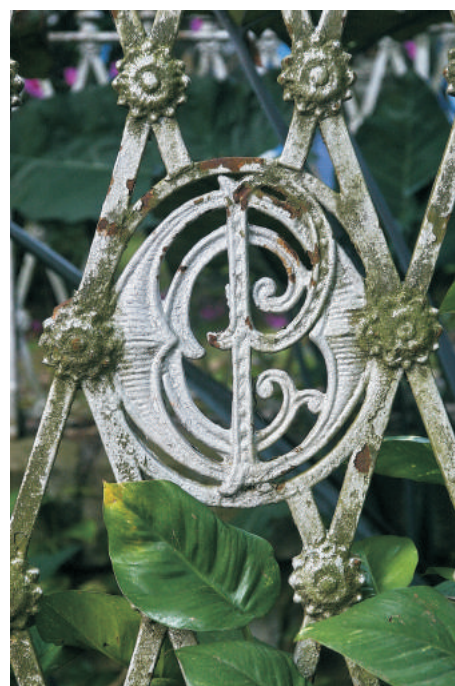
Detalhe do gradil. 08/2008
