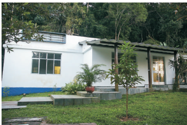
Sala de manobras. 08/2008
