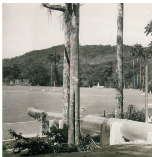
Reservatório já coberto.
