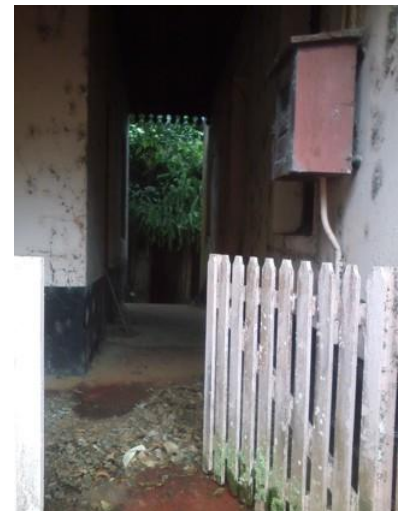
Foto 06. Corredor de acesso à casa enxaimel
