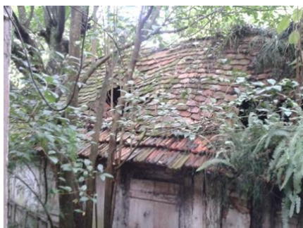
Foto 16. Casa enxaimel Situação do telhado.
