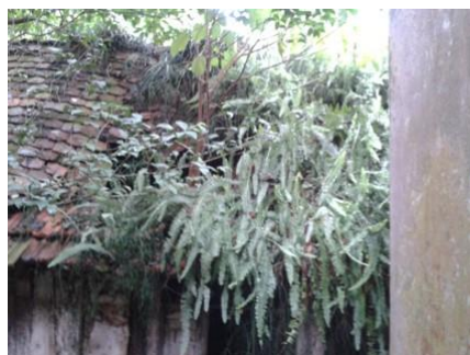
Foto 17. Casa enxaimel Situação do telhado.
