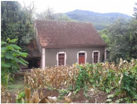
Foto 01. Vista da casa (sala de estar e dormitórios)
