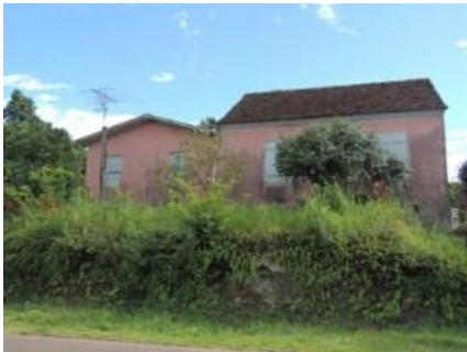
Foto 17. Vista da fachada sul.
