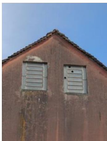
Foto 07. Janelas (oitão alterado)
