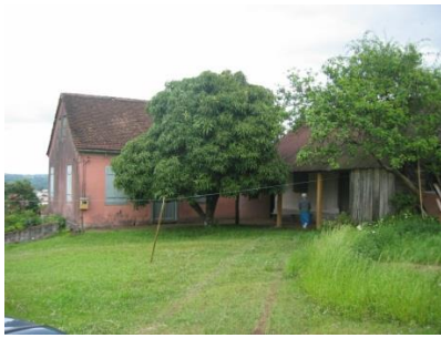
Foto 10. Janelas (oitão alterado)
