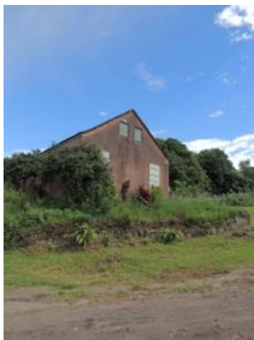
Foto 02. Fachada Lateral (leste)
