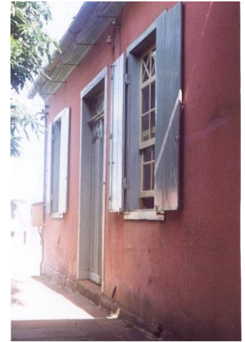
Foto 12. Janelas (oitão alterado)
