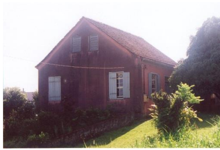
Foto 11. Janelas (oitão alterado)
