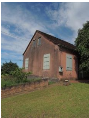
Foto 01. Vista do acesso
