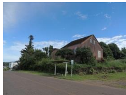
Foto 06. Vista da esquina
