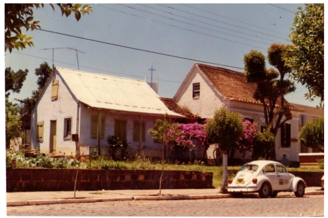
Vista geral das duas edificações Fonte: Acervo pessoal de Heriberto Kolling.
