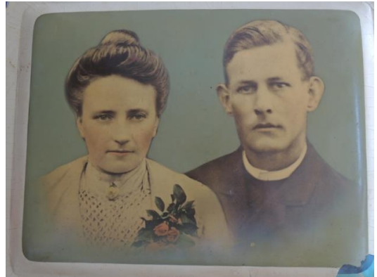
Antigos proprietários da edificação. Fonte: Acervo pessoal de Larissa Weber.
