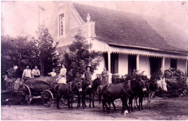
Vista da edificação antes do rebaixamento da Av. São Miguel. Fonte: Acervo do Museu Histórico Municipal de Dois Irmãos.
