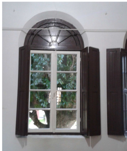
Vista interna da janela.
