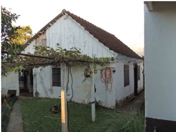
Casa Enxaimel existente no fundo do lote.
