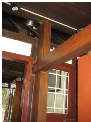
Vista da intervenção estrutural realizada. Não faz parte da estrutura original da casa.
