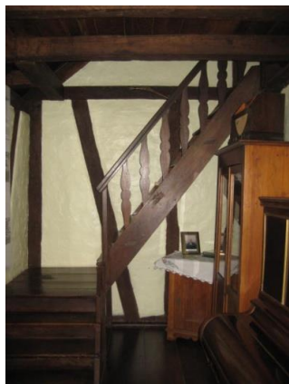
Vista da escada de acesso ao sótão.
