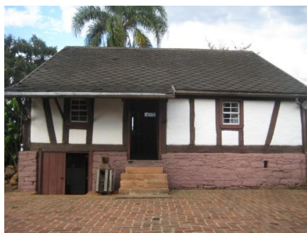
Foto 02. Fachada Fundos – Oeste
