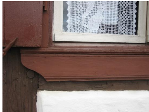
Detalhe externo janelas
