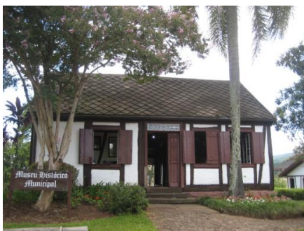
Foto 01. Fachada Principal - Leste
