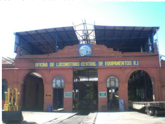
Figura 33 – Oficina de Locomotivas / rotunda de Barra do Pirai
