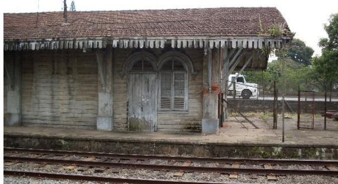
Figura 40 – Galpão integrante do Conjunto Ferroviário de Agulhas Negras
