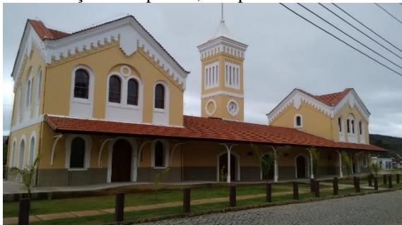
Figura 43 – Estação de Juparanã, recuperada em 2015 – Valença/RJ
