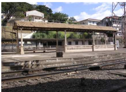
abrigo na plataforma
