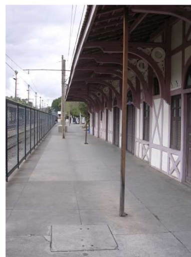
fachada da plataforma
