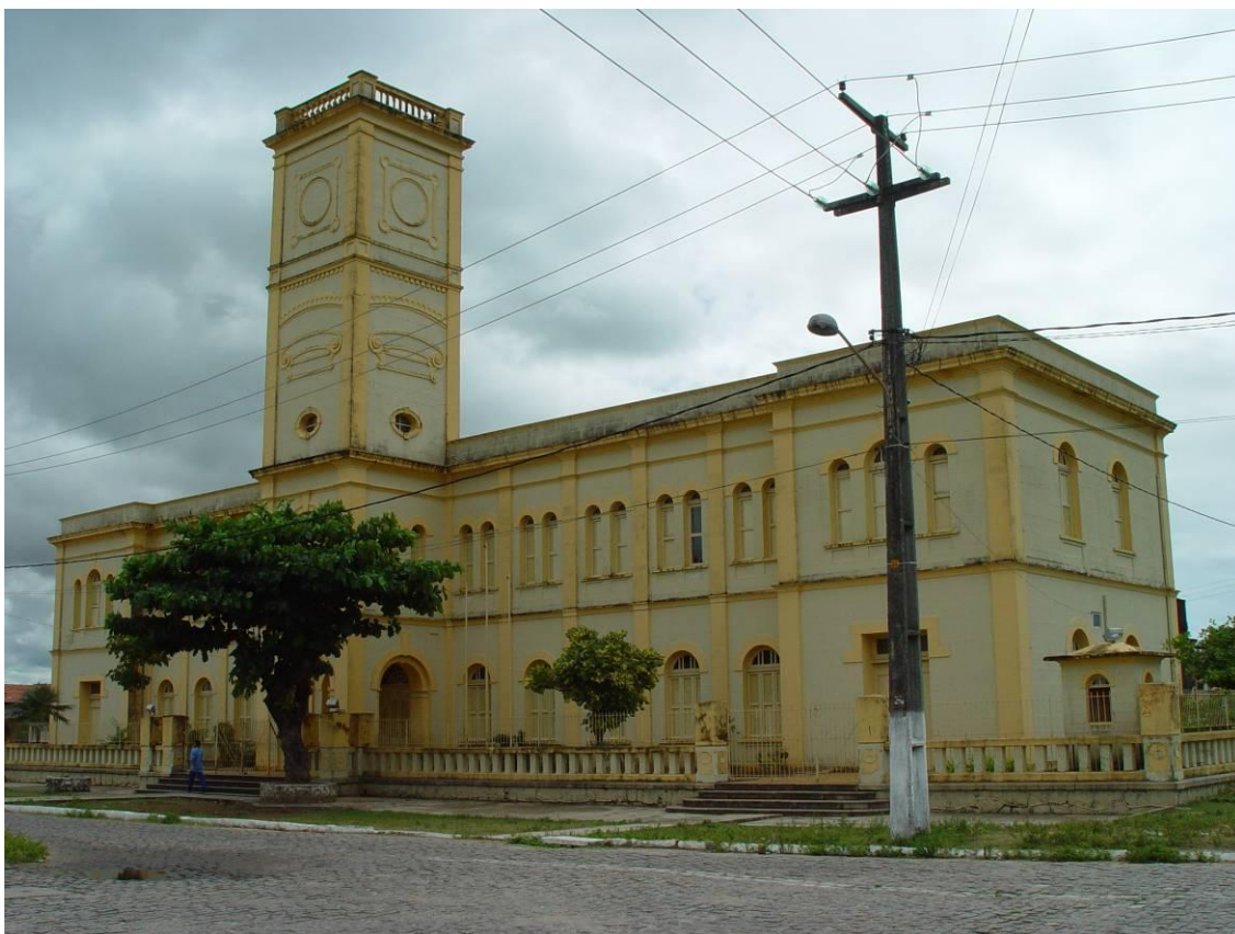
Fig. 13 – Predio que foi projetado para a Estação Central da EFCRGN. O prédio segue a tipologia clássica das Estações de trem, possuindo ainda uma torre que viria receber um relógio, que se tornaria um novo marco de referência na cidade. Atualmente está desocupado. Foto: Thaysa Fernandes, 2006.
