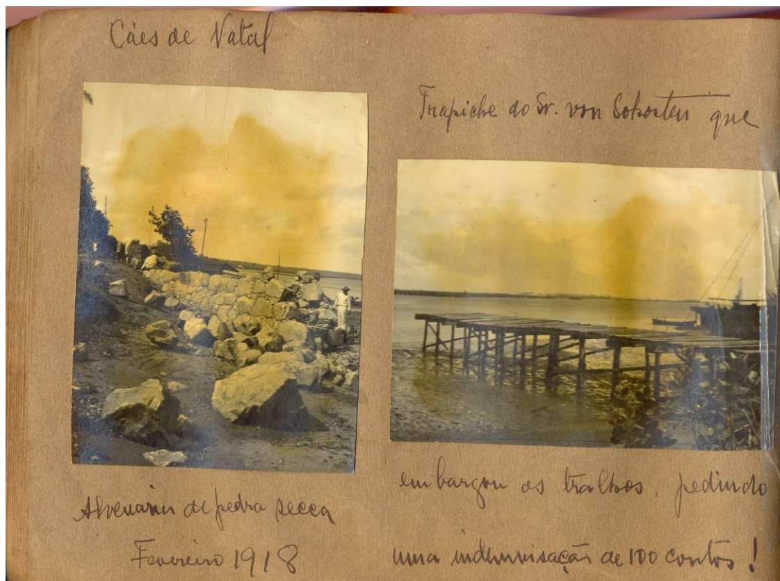
Fig. 11 – Página do álbum do engenheiro fiscal João Sá e Benevides. Do lado esquerdo, o sólido e moderno do cais feito em “Alvenaria de pedra secca”, do lado direito o precário trapiche do comerciante que, embarga os trabalhos e pede “uma indemnização de 100 contos!”.
