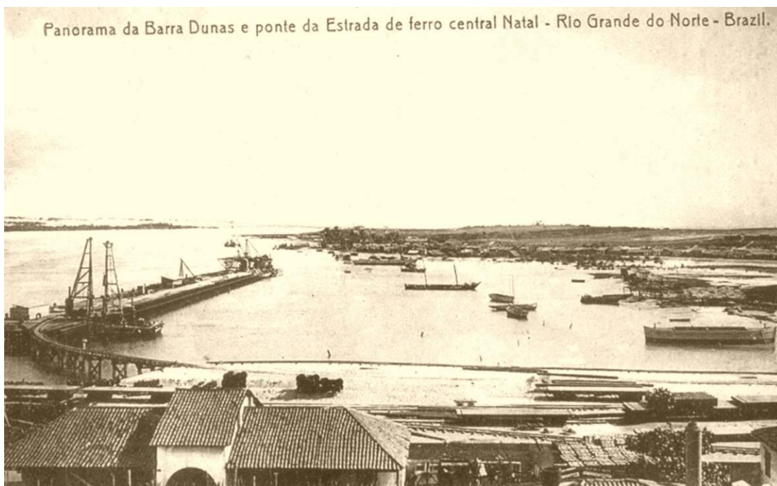
Fig. 03 – Postal das Obras de implantação da ponte de atracação da EFCRGN e da “Barra Dunas”. A interação entre as obras portuárias e ferroviárias na modificação da paisagem é visível nesse postal do início do século XX. Essa ponte seria o futuro atracadouro do porto de Natal, cujos armazéns seriam construídos apenas em 1928, no local do alagadiço onde estão atracadas pequenas embarcações. Já a “Barra Dunas” é a fileira de casas das Rocas que permitiram a fixação das dunas da Limpa. Nesse postal, que pretende propagandear as obras da Estrada de Ferro e da Comissão de Melhoramentos do Porto de Natal, os casebres dos retirantes aparecem como uma importante obra modernizadora da engenharia portuária e não como uma ocupação insalubre e indesejada. Fonte: LYRA, Carlos. Natal através do tempo, p. 58.
