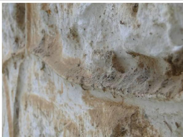
**Foto 42.** Detalhe da bossagem da argamassa das faces externas da caixa d'água.
