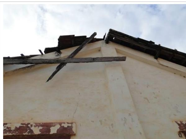
**Foto 502.** Detalhe dos danos existentes no telhado da Casa do Encarregado.
