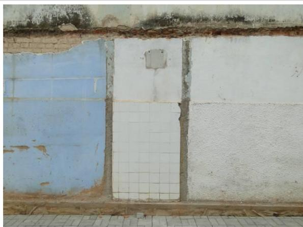
**Foto 36.** Vista parcial da fachada lateral direita da estação ferroviária. Notam-se os resquícios das paredes do anexo que foram demolidas e dos revestimentos cerâmicos que restaram.
