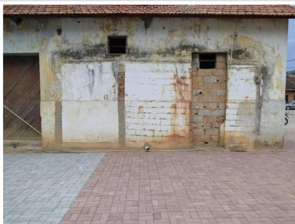
**Foto 35.** Vista parcial da fachada posterior da estação ferroviária. Notam-se os resquícios das paredes do anexo que foram demolidas.
