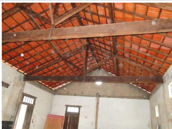
**Foto 28.** Detalhe da estrutura em madeira do telhado
