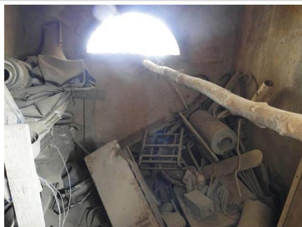
**Foto 47.** Vista interna da caixa d'água. Nota-se o grande acúmulo de entulho.
