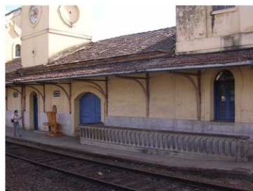
plataforma vista da linha férrea
