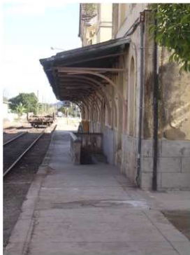
plataforma com entrada da passagem subterrânea
