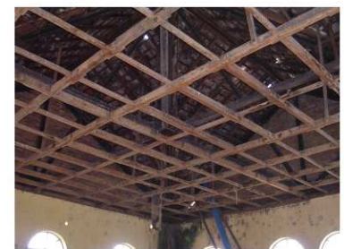
estrutura do telhado
