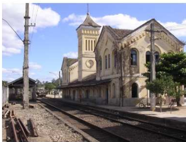
vista da linha férrea
