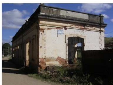
vista da estrada
