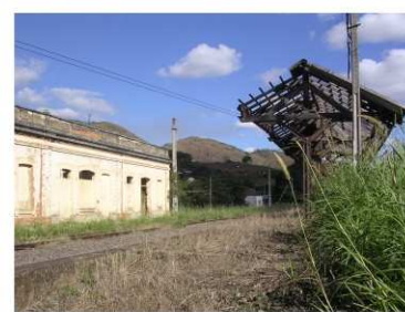
vista da linha férrea
