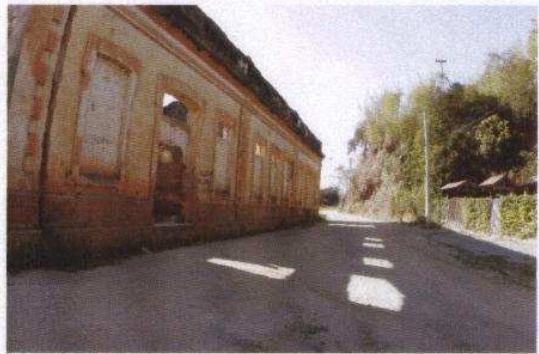
Vista pela estrada de rodagem
