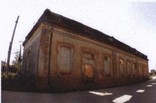
Vista pela estrada de rodagem
