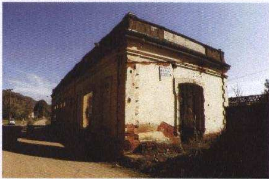
Vista pela estrada de rodagem
