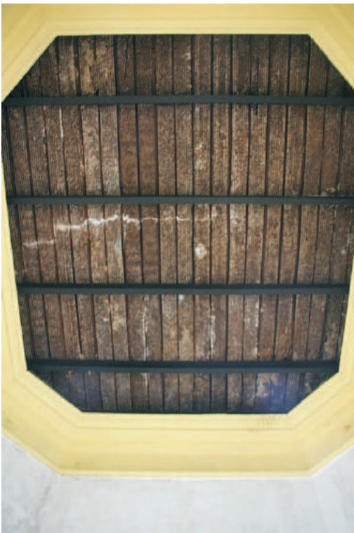
Forro da casa de manobras. Julho/2006
