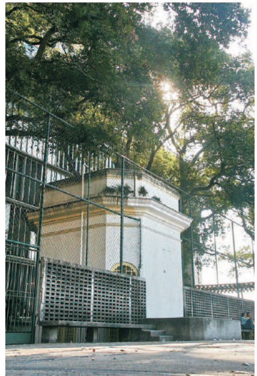
Casa de manobras. Julho/2006
