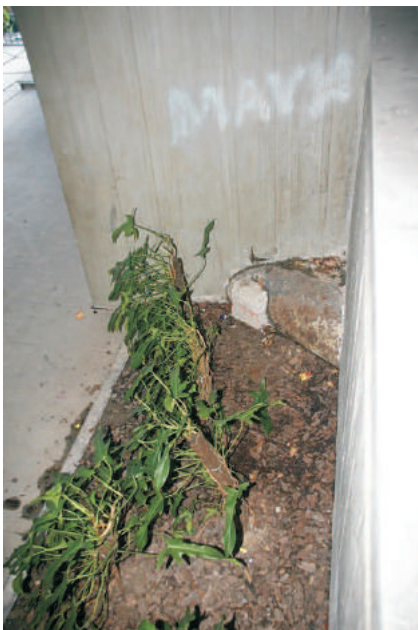
Detalhe de tubulação. Julho/2006
