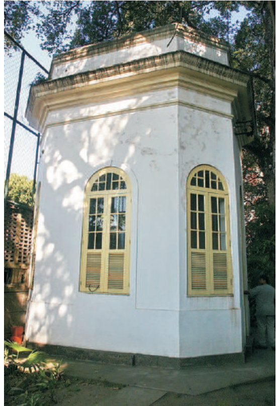
Casa de manobras. Julho/2006
