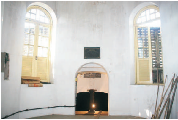
Casa de manobras com visita ao reservatório. Julho/2006
