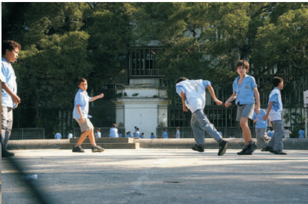
Casa de manobras e campo sobre o reservatório. Julho/2006
