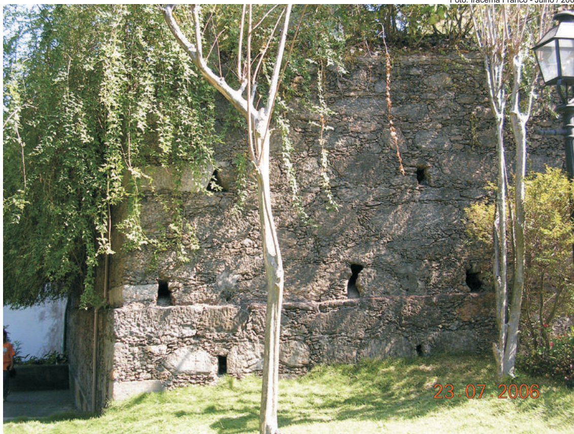
Muro de Arrimo do platô de assentamento do Reservatório do Morro de São Bento.
