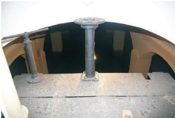
Visita ao reservatório . Julho/2006
