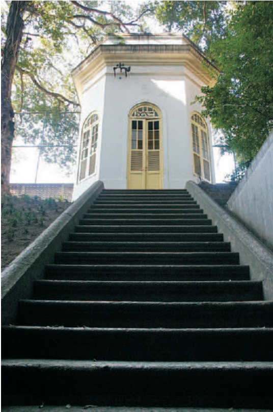
Casa de manobras. Julho/2006
