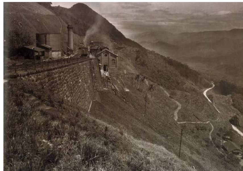
Figura 39 – Trecho dos novos planos inclinados. Abaixo parte do primeiro sistema.
