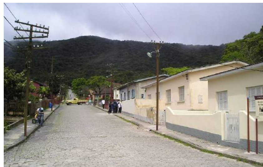
Figura 76 – Conjunto de edificações em alvenaria.
