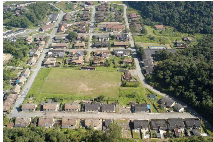
Figura 79 – Vista aérea da Vila Martin Smith com campo de football .
