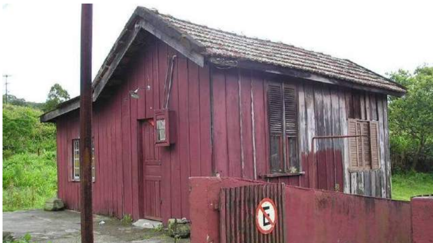
Figura 54 – Edificação residencial isolada na Vila Velha Foto: Anna Finger, 2008.
