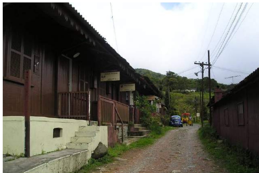
Figura 55 – Habitações em bloco, na Vila Velha. Foto: Anna Finger, 2008.
