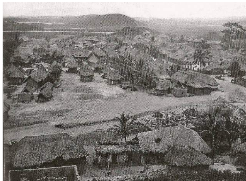
Figura 28 – Acampamento para operários que trabalhavam na construção da São Paulo Railway , na Raiz da Serra, por volta de 1865.
