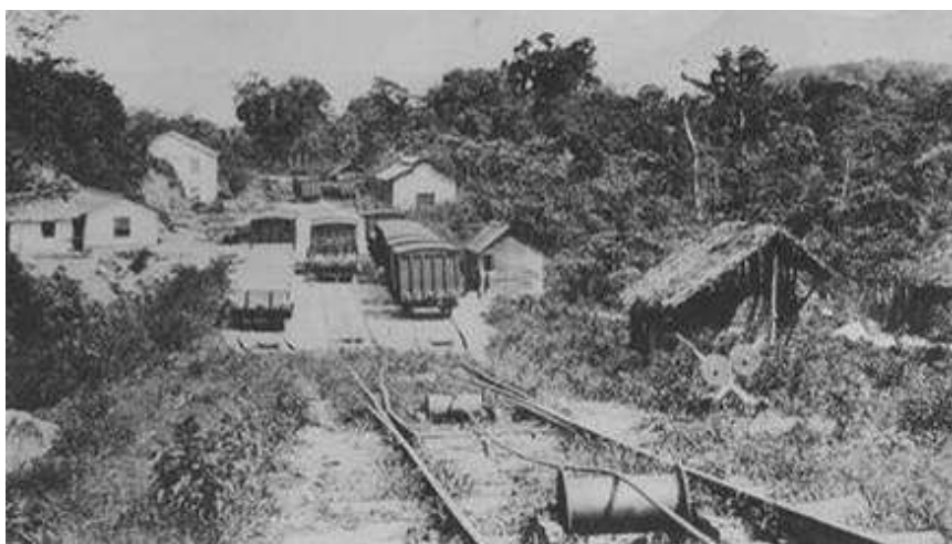
Figura 37 – Primeiro patamar, onde se observa o sistema de cabos de tração.
