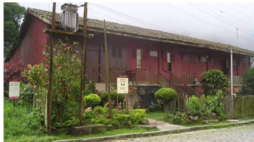
Figura 67 – Fachada da Tipologia “E1”
