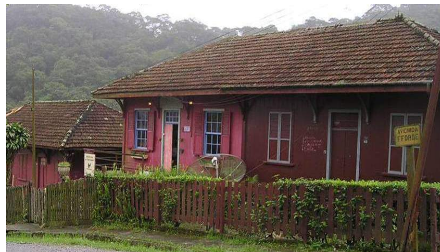
Figura 63 – Fachada da Tipologia “B”.
