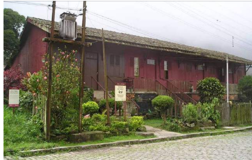
Figura 51 – Bloco de edificações residenciais.
