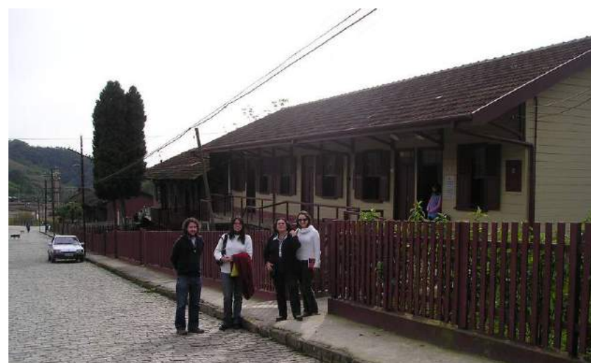
Figura 71 – Fachada da Tipologia “E2”.
