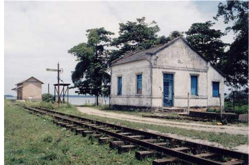
Figura 26 – Casa de Agente próxima à Estação Guia de Pacobaíba, no fundo da Baía da Guanabara, Rio de Janeiro.
