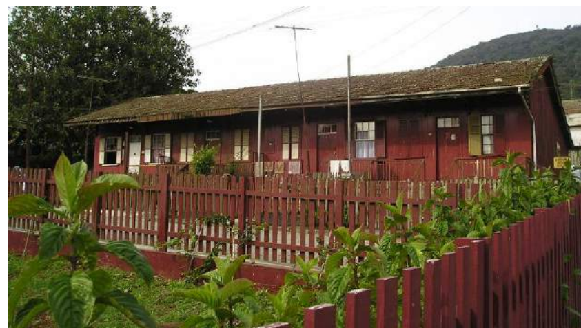
Figura 70 – Fachada da Tipologia “E2”.
