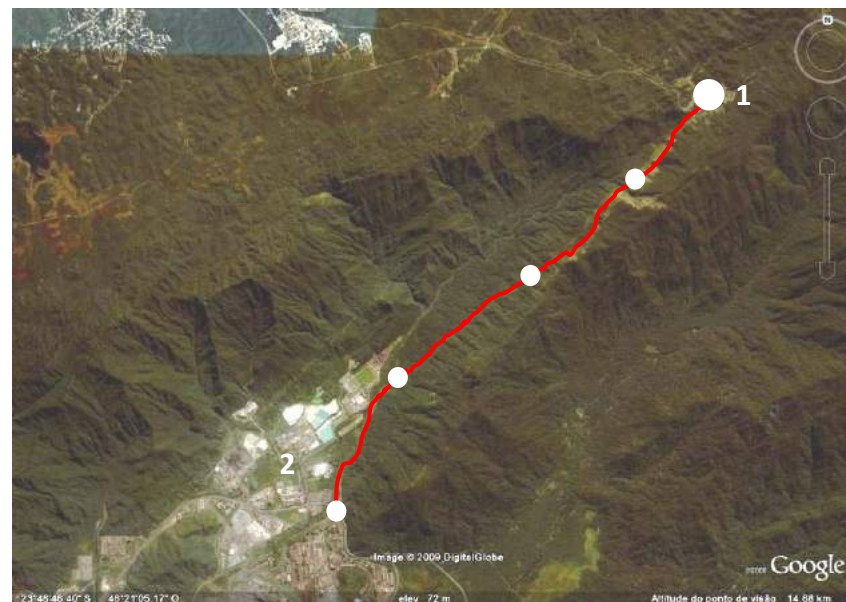
Figura 35 – Imagem do trecho Vale do Rio Mogi, na Serra do Mar, onde foi implantado o sistema funicular.
