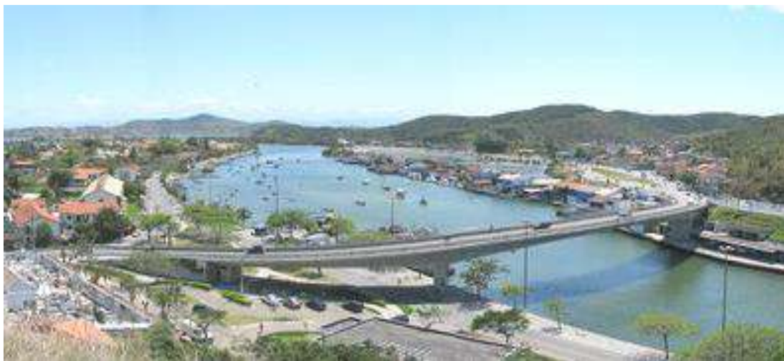
Ponte Nova inaugurada em 2004 (Fonte: internet)
