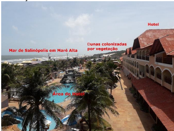
Figura 18: Hotel construído à 50 metros de distância da linha de espraiamento das ondas em maré alta e a 7 metros do Nível Médio do Mar, localizado na área central da praia do Atalaia.
