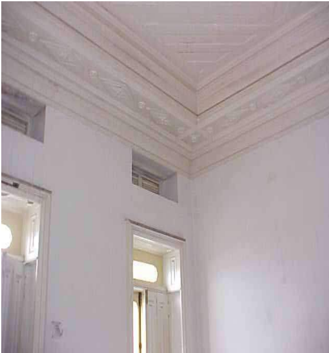
Foto 34 – Detalhes de aberturas nas paredes sobre portas e janelas externas do palacete. Funcionam como exaustores retirando o ar quente acumulado junto ao forro. Observar armadores de rede nas paredes dos quartos, um costume da região. Destaca-se o detalhe do forro em madeira elaborado com aplicações, volumetria e marcenaria esmerada.
