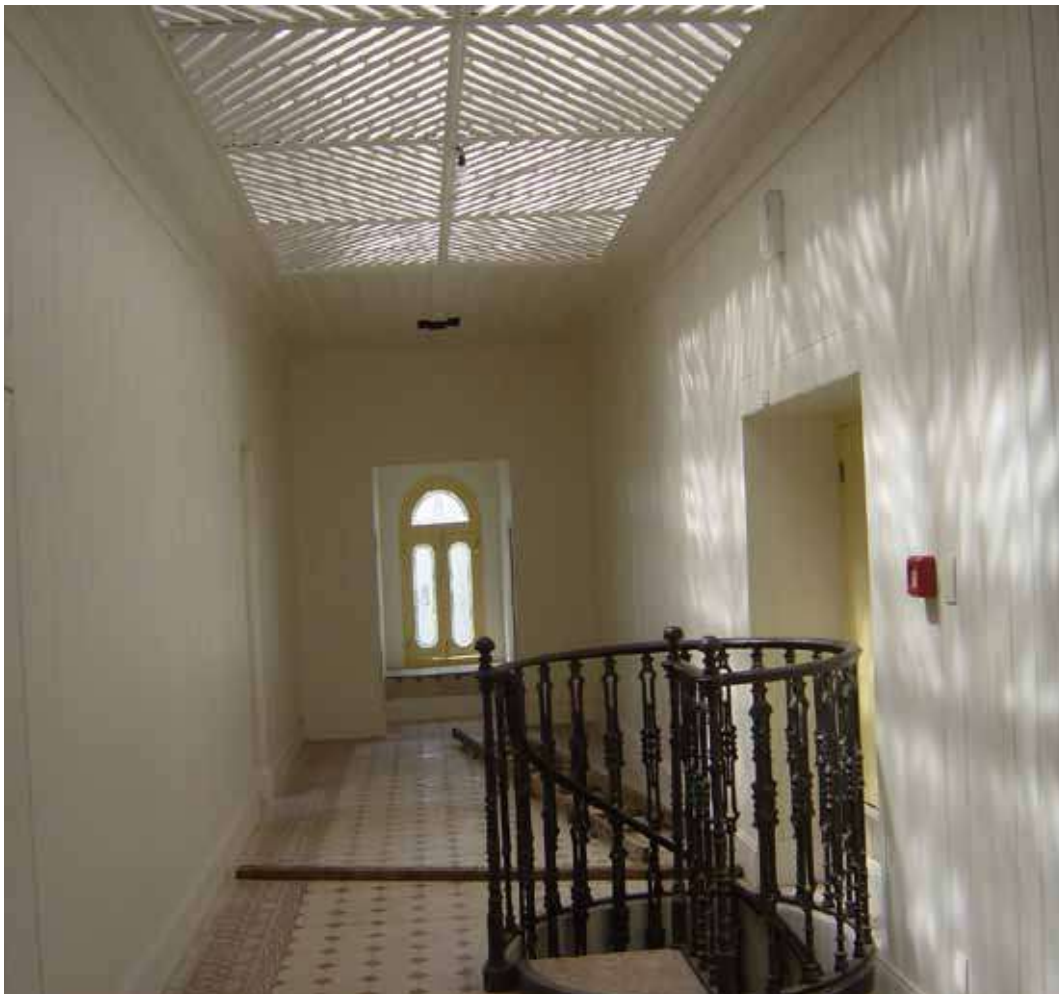
Foto 35 - Detalhe da “chegada” de escada original na mansarda no 4º pavimento do palacete. Esse espaço era usado como depósito e também mirante por seus furta águas. Ao fundo, sob a janela, a “conversadeira”. Observar o piso em ladrilhos com detalhes.
