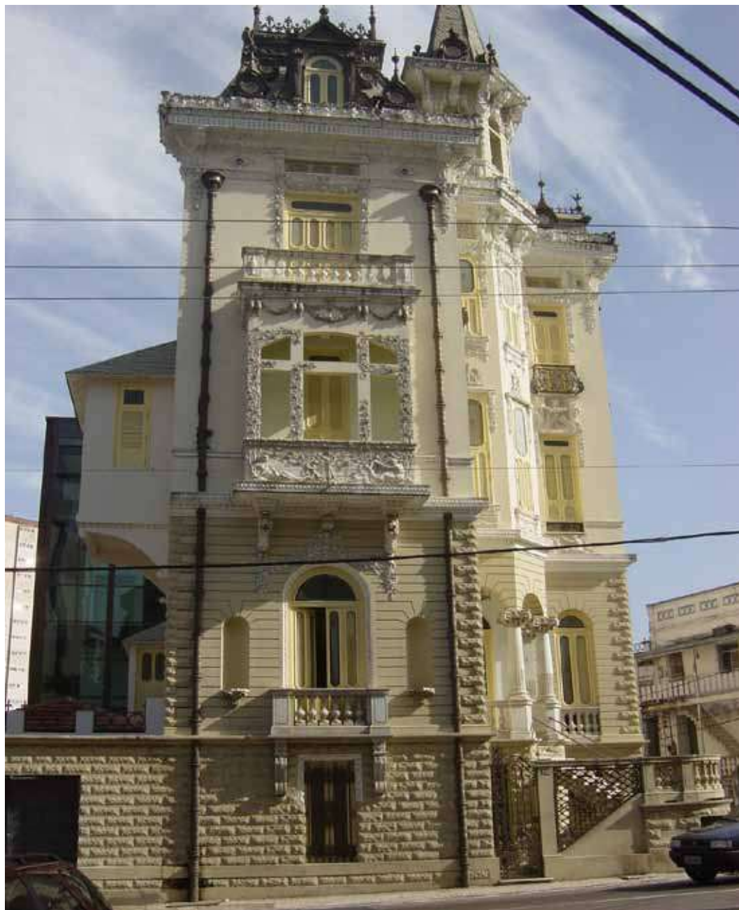
Foto 38 - Fachada frontal do Palacete Bolonha
