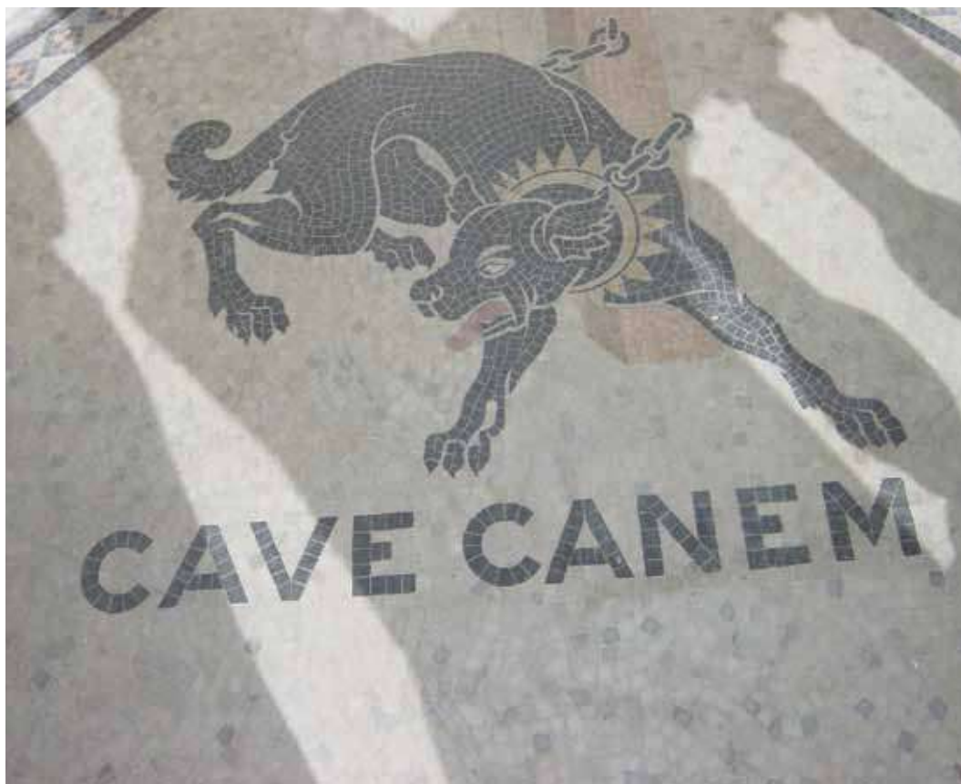
Foto 6 – Detalhe de piso em pastilhas (acesso coberto que antecede a sala de visitas/música).
