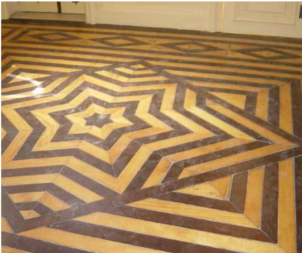
Foto 11 – Detalhe de piso com tábuas de acapú e pau amarelo.
