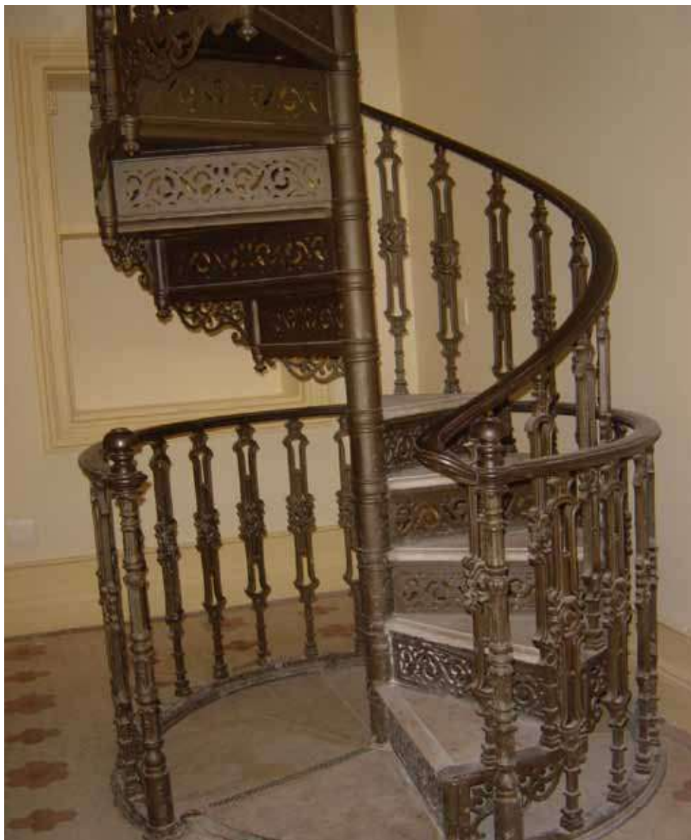
Foto 33 – Detalhe de escada social entre o 3º e 4º pavimento que permanece como elemento arquitetônico original com estrutura metálica, balaústres e espelhos da escada trabalhados e pisos em mármore. É a ligação entre as áreas privativas do palacete. Somente os membros da família circulavam por essa escada. As outras escadas, as de serviço, foram vendidas e retiradas do palacete.
