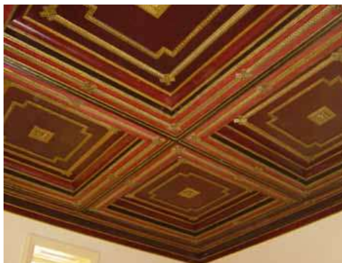
Fotos 14 e 15 - Detalhes de forros em madeira de lei com pintura e douramento.
