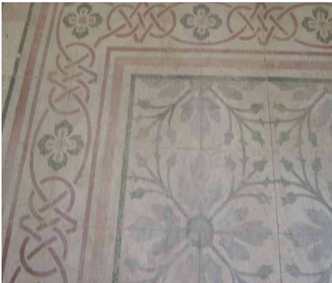
Foto 8 – Detalhe de piso em lajotas
