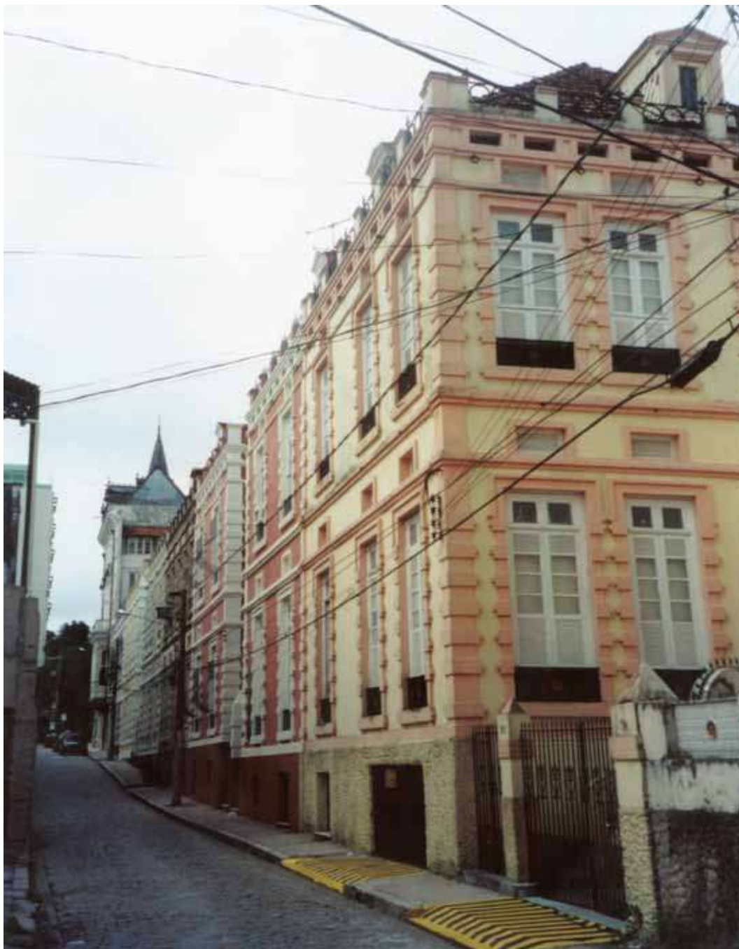
Foto 21 - Vila Bolonha, ao fundo a direita, o Palacete Bolonha.
