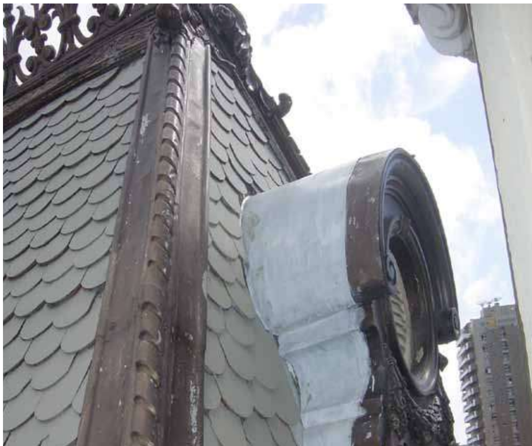
Foto 18 – Detalhe da cobertura com telhas planas em ardósia, elementos em metal e furta água.
