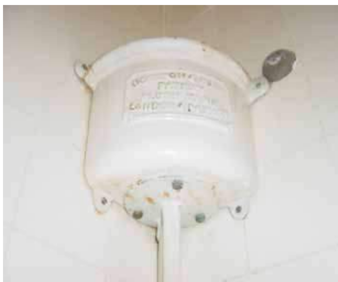
Foto 19 – Detalhe de descarga sanitária em metal importada da Inglaterra. Produzido por Doulton & Co Limited Patent - London.
