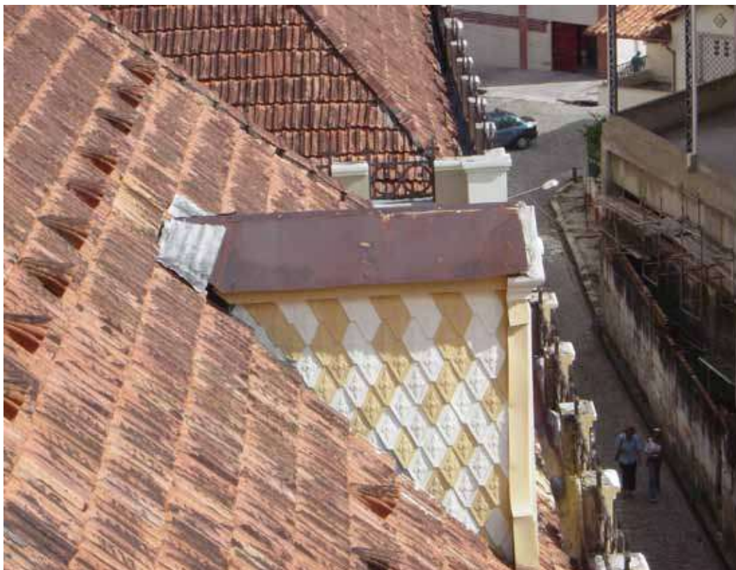
Foto 20 - Detalhe da cobertura das casas da Vila Bolonha, com telhas tipo francesas e a esquerda, estas com respiradouros. No centro da foto, uma “água furtada”.
