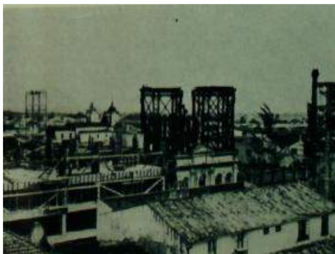
Figura 37 - Rara foto do desmonte do reservatório (1965) 44
