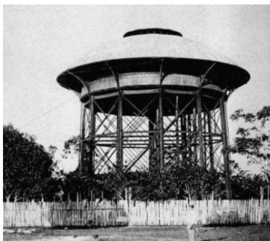
Figura 17 - Reservatório de ferro de São Brás (1898)
