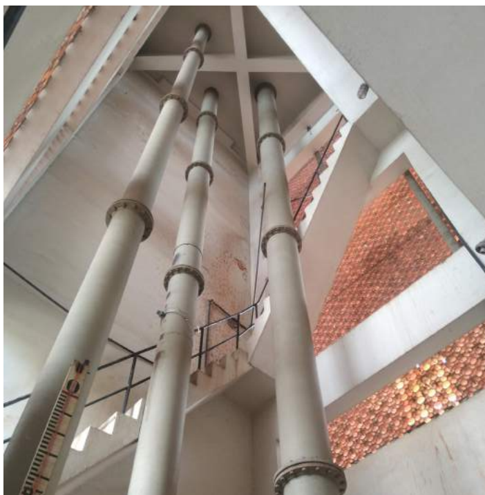
Figura 42 - Vista interna do reservatório moderno
