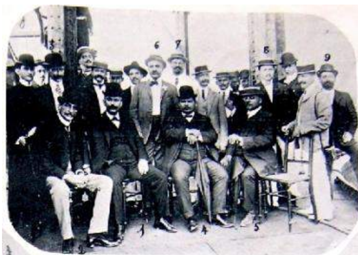
Figura 21 - Equipe responsável pela montagem reservatório
