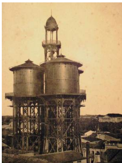
Figura 58 - Reservatório d’água para abastecimento da cidade (1910)
