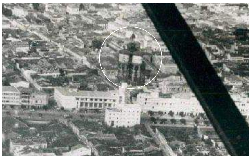
Figura 87 - Ampliação da imagem anterior com destaque para a Caixa D'Água
