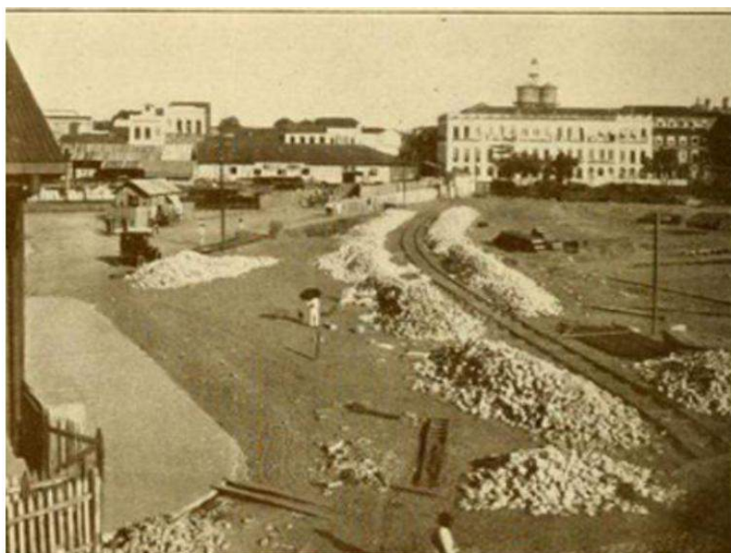
Figura 69 - Aterro do Boulevard da república com reservatório ao fundo (1912)
