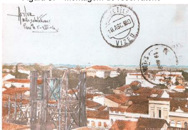
Figura 57 - Montagem do reservatório
