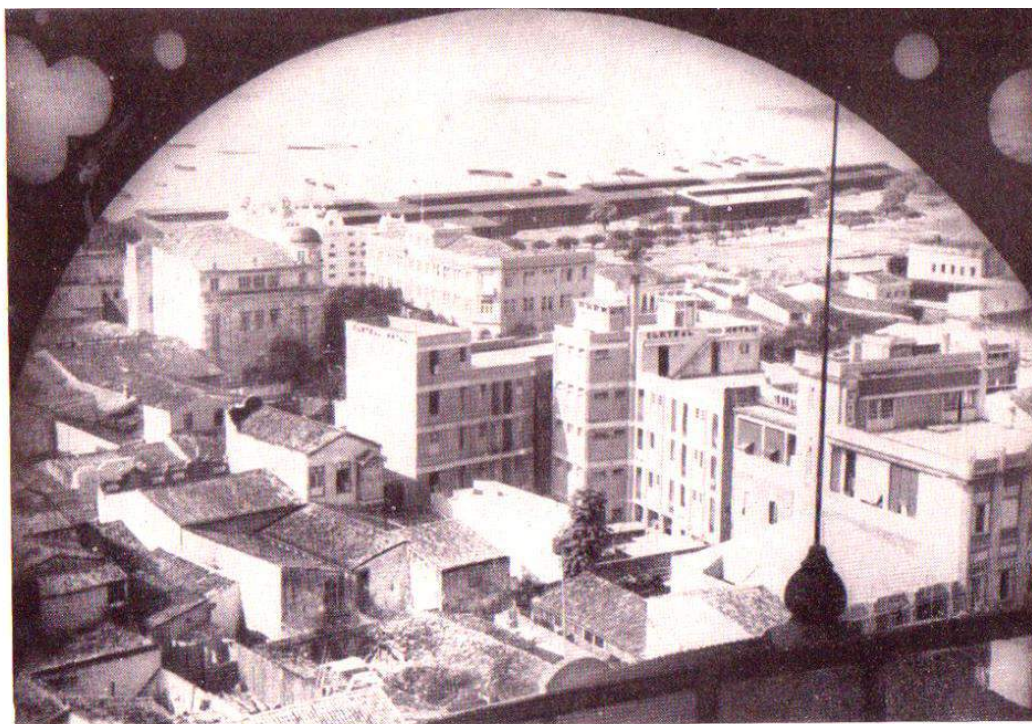
Figura 96 - Vista da cidade tomada do reservatório
