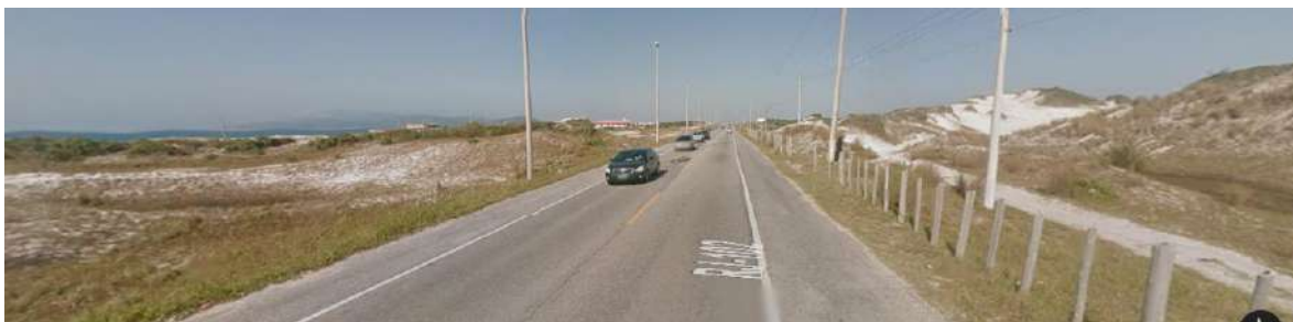
Figura 14 - Rodovia Gen. Bruno Martins (RJ-102), sentido Arraial do Cabo. Importante via de ligação entre Cabo Frio e Arraial do Cabo. Observa-se a formação de dunas nos dois lados. À direita é possível ver os mourões que delimitam a área protegida. Fonte: Adaptado de Google Street View (2015).
