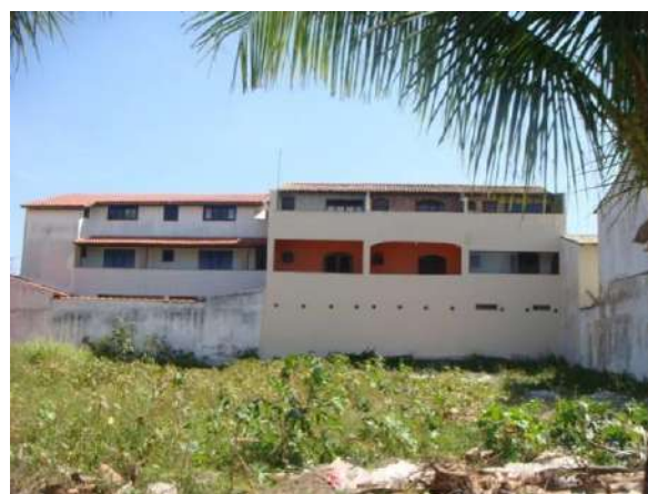
Figura 21 - Imóvel construído sem respeitar os parâmetros de construção do Estado. Fonte: a autora (2015).
