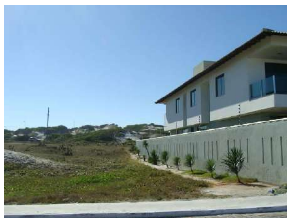
Figura 29 - Construção em área regular do loteamento, porém, muito próxima ao campo de dunas podendo comprometer sua alimentação, visto que a edificação situa-se entre o campo de dunas e a praia. Possivelmente havia dunas no lote antes da edificação da casa. Fonte: a autora (2015).
