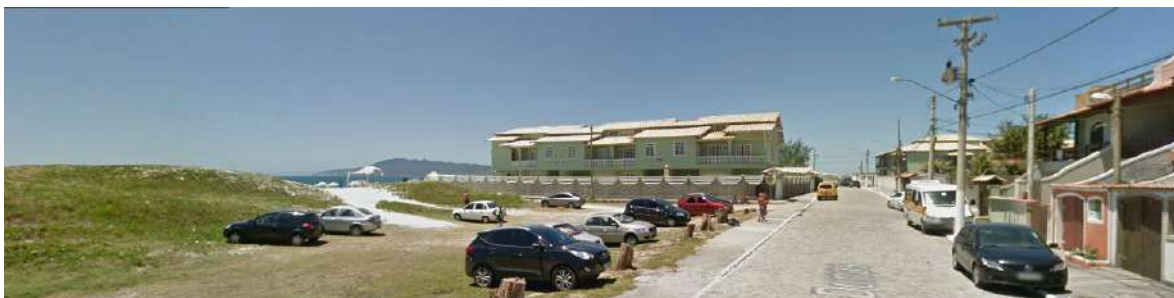
Figura 27 – Construção (à esquerda) em área non-aedificandi lindeira a praia considerada “Parque (municipal) das Dunas”. Imagem set. 2011. Fonte: Google Street View (2016).
