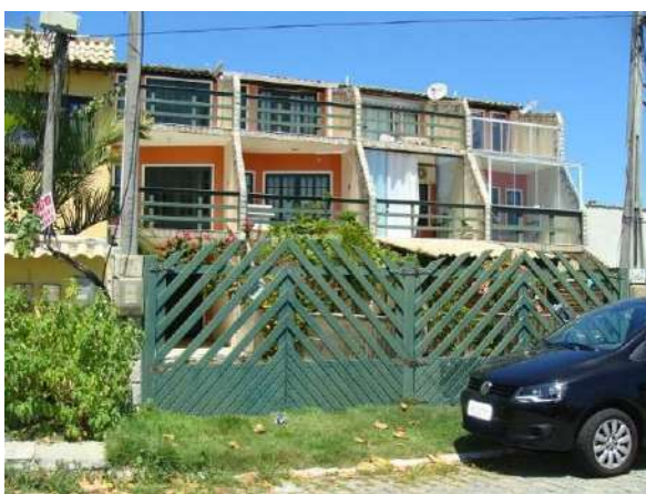
Figura 20 – Imóvel construído sem respeitar os parâmetros de construção do Estado. Fonte: a autora (2015).
