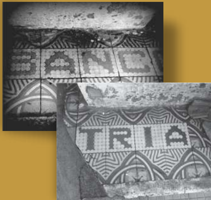
Detalhe dos ladrilhos
