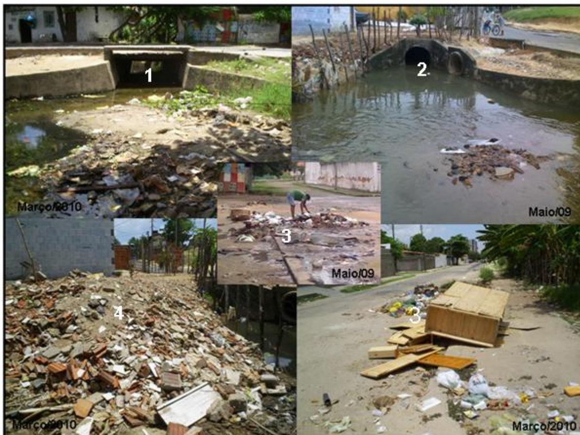
Figura 34 – Agressões ao riacho Papicu. 1 - canal do riacho Papicu sob a rua José Carlos Gurgel Nogueira; 2 - Galeria de esgoto; 3 – deposição inadequada de lixo; 4 – entulhos e aterro do canal do riacho Fonte: Arquivo próprio (2010)
