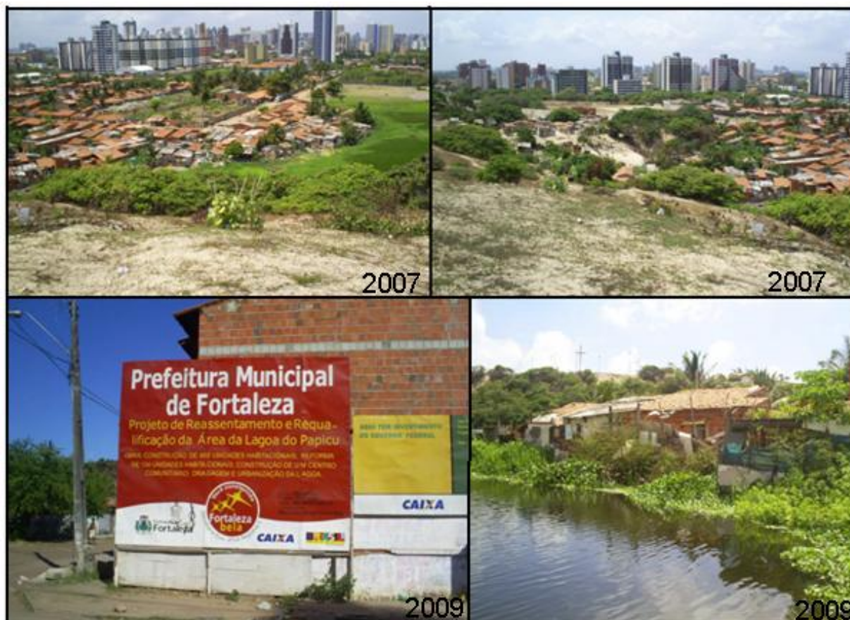
Figura 32 – Ocupação da área da Favela Paufininho Fonte: Arquivo próprio (2007 e 2009)
