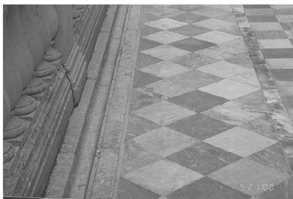
Piso em mármore do Teatro de Santa Isabel – Recife/PE assentamento em diagonal –
