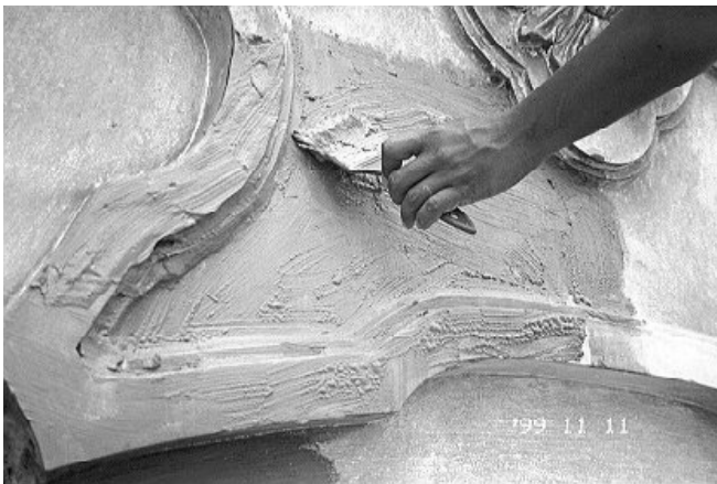
Limpeza de Cantaria - Suporte Lama Betonita – Fachada da Igreja de N. Sra. da Ordem Terceira do Carmo do Recife – PE
