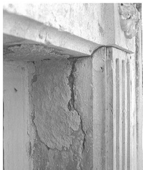
Limpeza Química de Cantaria - bicarbonato + EDTA – Suporte Polpa de Papel. Portada do Teatro Apolo – Recife/PE
