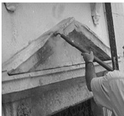
Limpeza através de Vapor d'água Foto: Frederico Almeida
