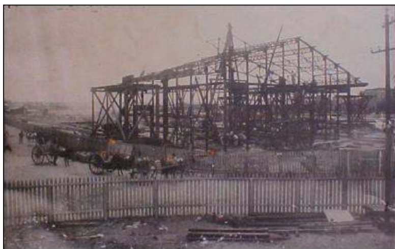
Fig. 53: Montagem dos Armazéns pré-fabricados de origem europeia.
