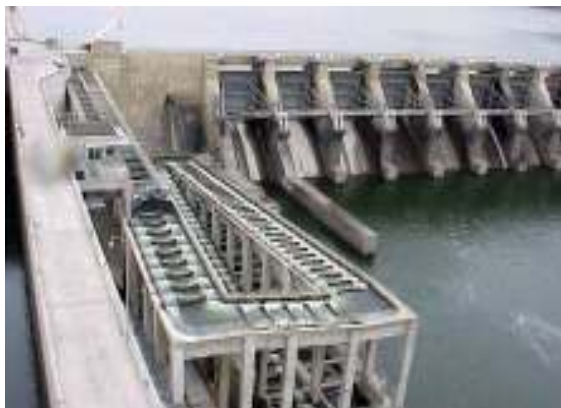
Fig. 94: Ao centro em primeiro plano a "Escada de Peixes" e ao fundo a Hidrelétrica e Lago em John Day , na localidade de Rufus, Oregon, EUA. Fotos do Relatório de Viagem aos Estados Unidos da América , período de 06 a 19/04 de 2001, pelo engenheiro Antonio Alberto Pequeno de Barros/CDP/MT.
