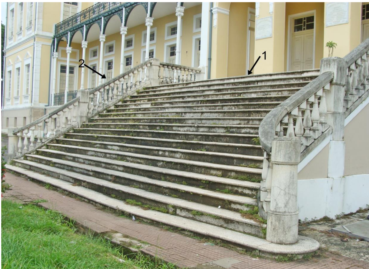
Figura 05. Escadaria. 1 – Escada em Marmorite; 2 – Parapeito com balaustradas clássicas. Fonte: Acervo da autora. 2015.
