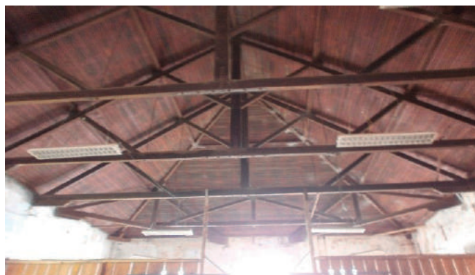
Figura 12 - Imagem mostrando as treliças da preexistência/armazém 3.
