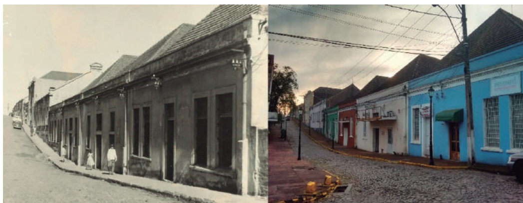
Figura 14 - Imagens mostrando a descaracterização dos prédios da COOPFER de 1953 a 2016. Da direita para a esquerda, as preexistências 1, 2 e 3.
