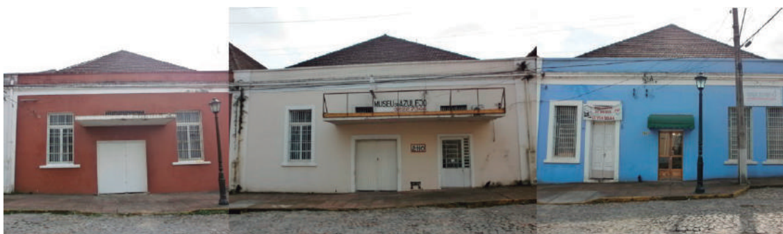
Figura 18 - Imagem das fachadas sul.
