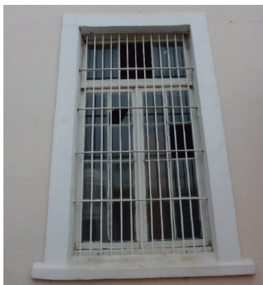
Figura 13 - Imagem mostrando uma janela da preexistência/armazém 2.
