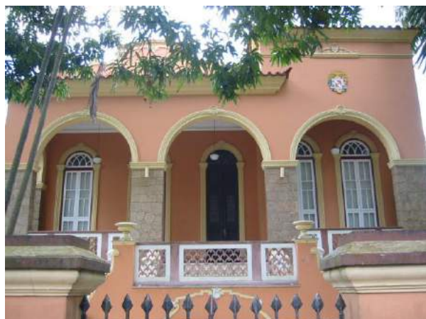
Figura 90: Fachada frontal da Residência José Chermont (04) em 2009.
