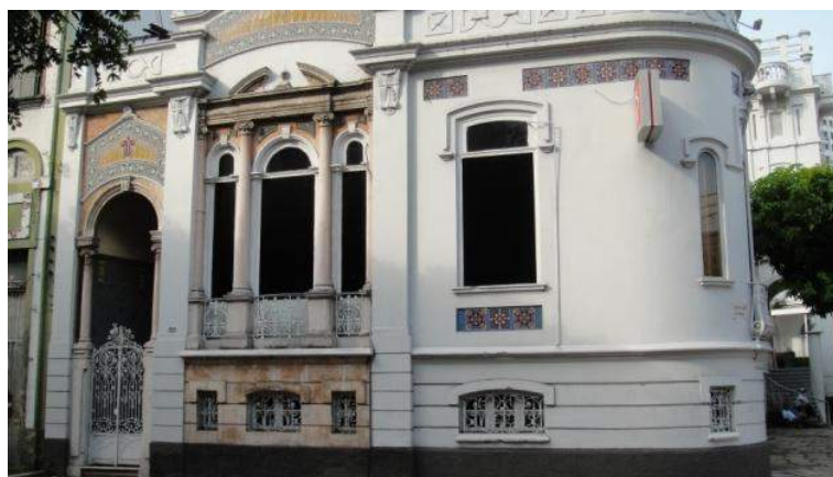
Figura 102: Fachada principal da Residência Manoel Dacier Lobato (08) em 2009.
