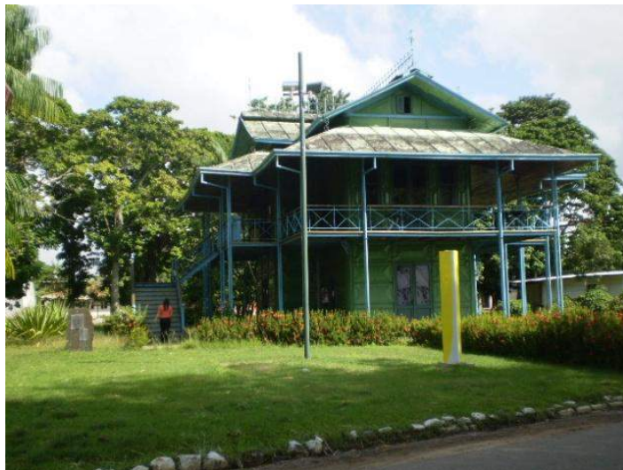
Figura 03: Exemplar de um Chalé de Ferro para uso residencial de origem Belga, com construção anterior à 1893. Está localizado atualmente no campus da Universidade Federal do Pará, em Belém.
