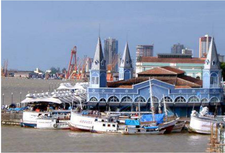
Figura 02: Mercado de peixe do Ver-o-Peso em Belém, inaugurado em 1901, com estrutura totalmente em ferro aparente trazido da Europa. Projeto de Henrique La Rocque.
