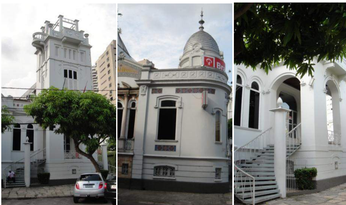
Figura 105: Detalhes do belvedere, da torre, e da escada de acesso para entrada (2009).
