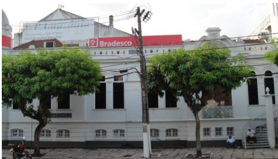
Figura 104: Fachada lateral da Residência Manoel Dacier Lobato (08), com destaque para o telhado parcialmente aparente, para o ritmo das esquadrias e para o discreto jogo de volumes (2009).
