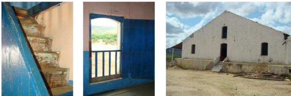
Escada; janela do sótão; lateral esquerda.
