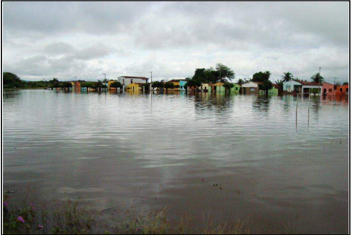
Foto 28 – Enchente no Bairro da Estação (Lívia Jordana, 2009)
