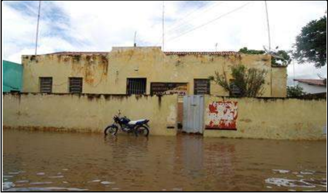
Foto 32 – Enchente no Bairro Central. Sede da Cadeia Pública Municipal (Lívia Jordana, 2009).
