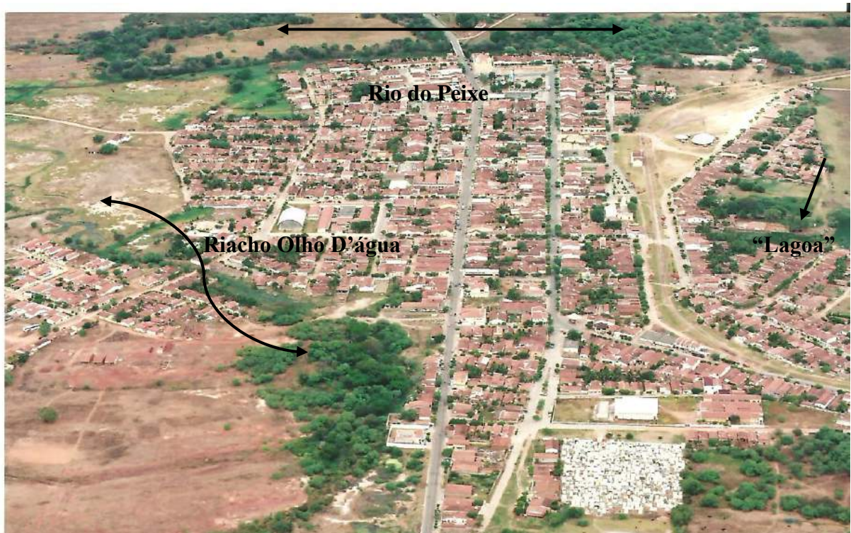
Foto 37 – Destino final dado a rede de coleta pública de esgoto (Lívia Jordana, 2009).
