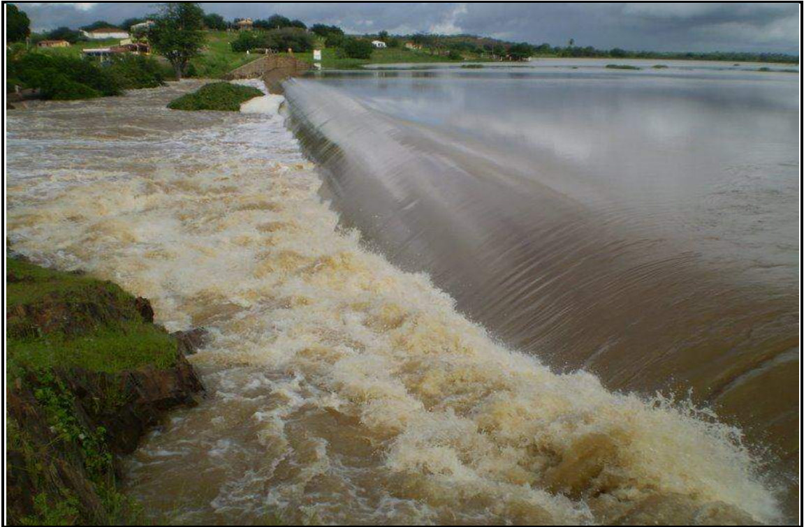
Foto 24 – Sangradouro do Açude Pilões, abril de 2009 (Lívia Jordana, 2009).
