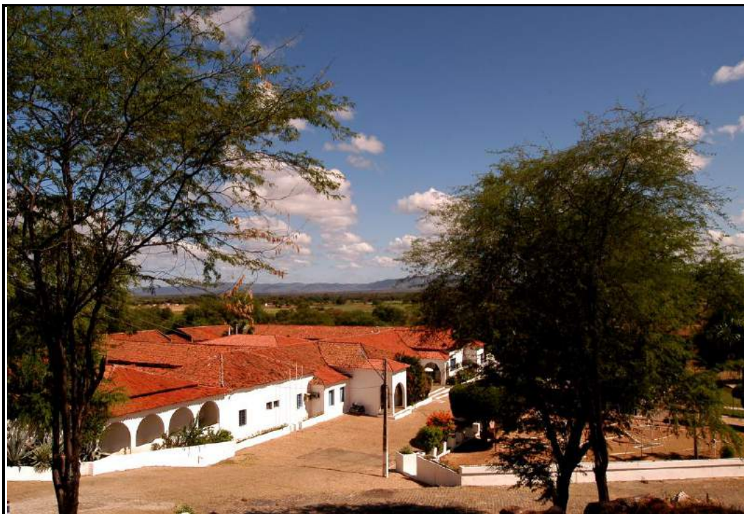
FOTO 03 – Hotel Estância Termal de Brejo das Freiras construído em 1944 (Lívia Jordana, 2009).
