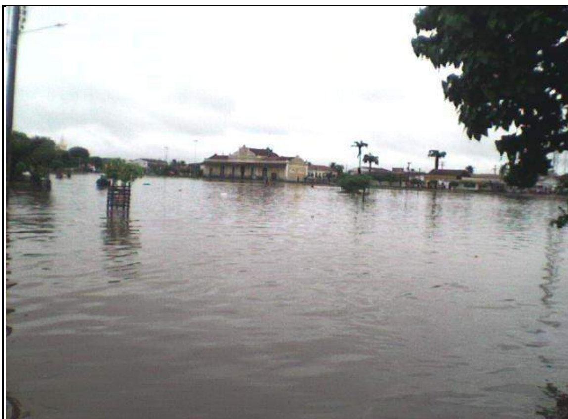
Foto 27 – Enchente no Bairro da Estação (Lívia Jordana, 2009)
