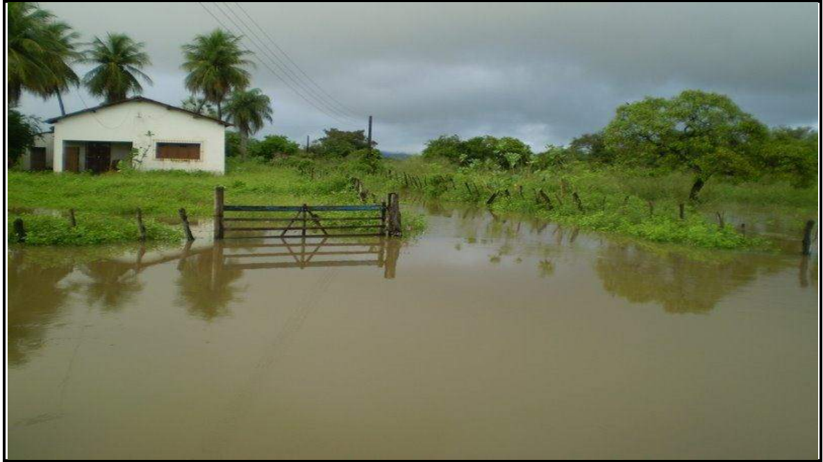
Foto 34 – Área alagada as margens da BR-405, proximidade do “Poço das Mangueiras” (Livia Jordana, 2009).
