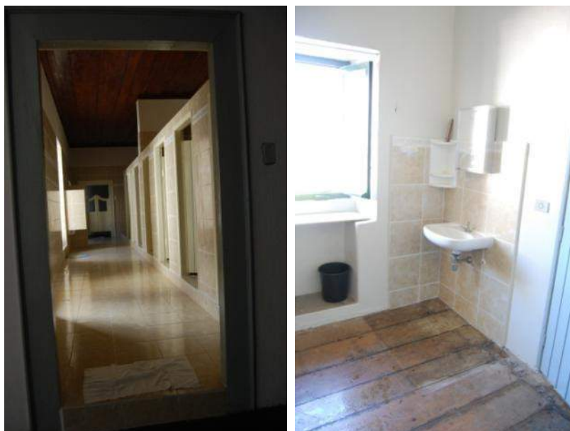
Figura 86 Banheiro do primeiro pavimento. Foto: Barbara Aguiar, fev./2009.
