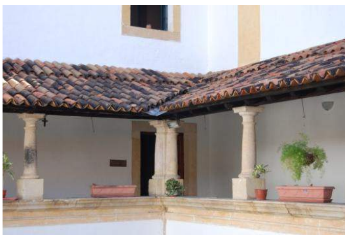
Figura 27 Colunas do primeiro pavimento do claustro. Notar que sua base é desproporcional aos outros elementos que a compõem. Foto: Barbara Aguiar, fev./2009
