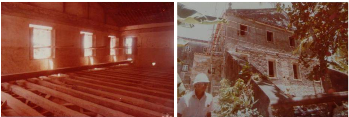
Figura 52 Sala de aula no primeiro pavimento, mostrando estrutura do forro da sacristia e assoalho da sala acima dela. Fonte: Acervo da Biblioteca Almeida Cunha – 5ªSR/Iphan, registro n° 6981/85.
