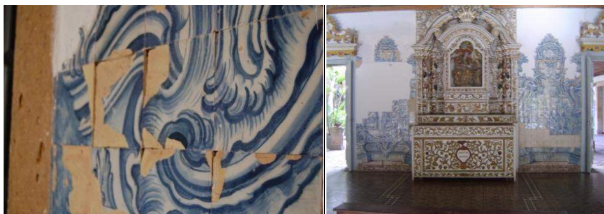
Figura 75 Exemplos de danos nos azulejos do claustro – perda do vidrado e trechos do biscoito. Foto: Barbara Aguiar, set./2008
