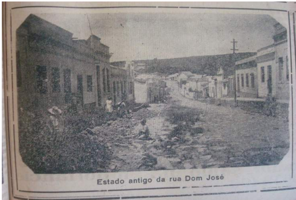
Figura 09 – Rua Dom José. Uma das principais do centro da cidade, na época residência das elites de Garanhuns. Foto antes de reformas. No mesmo periódico.
