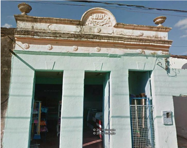
Figura 08 – Faixada da frente da casa antiga que hoje funciona uma panificadora.
