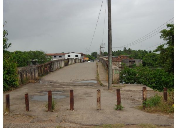
Figura 04 – Ponte Sanhauá atualmente
