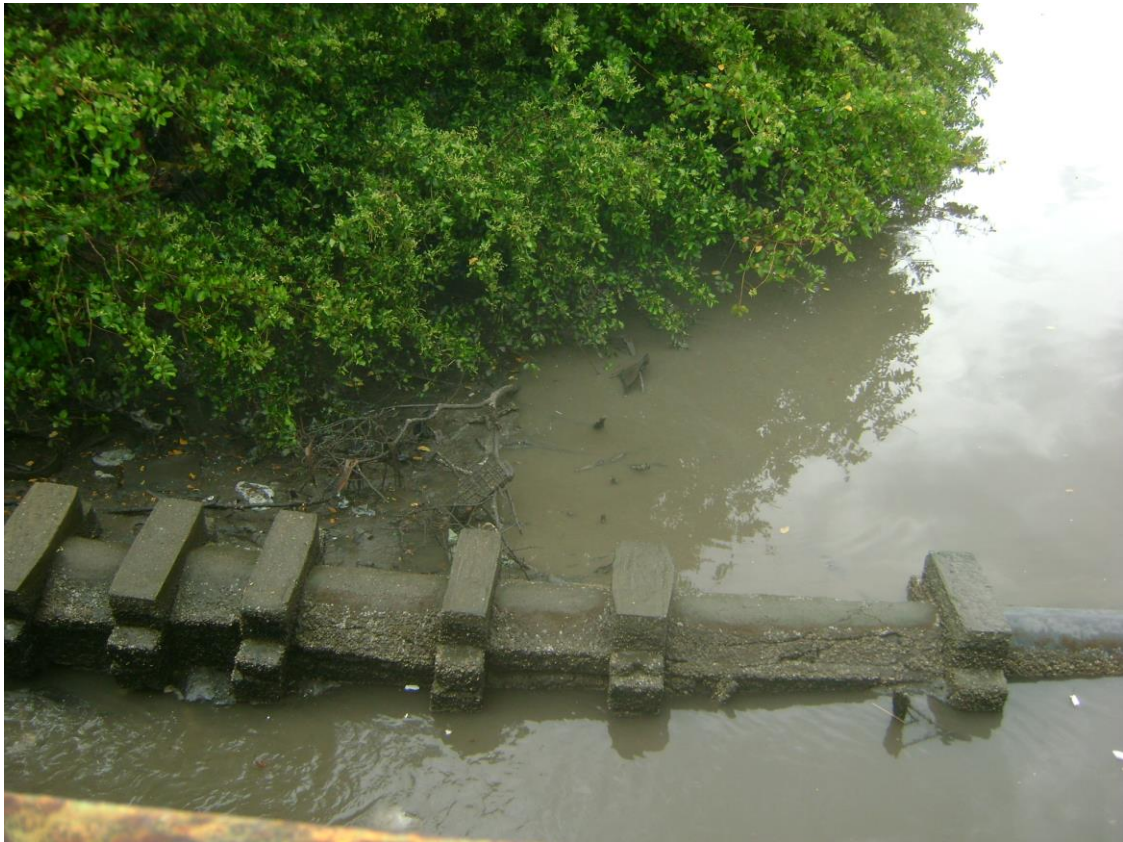
Figura 21 – Rede de esgoto de João Pessoa com destino ao Rio Sanhauá, próximo do bairro do Baralho.
