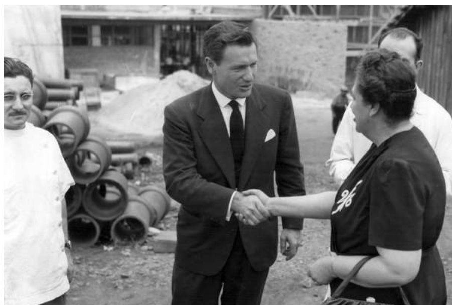
Nelson Rockefeller com Edith de Magalhães Fraenkel no canteiro de obras do edifício que abrigaria as instalações da Escola de Enfermagem de São Paulo, atualmente, Escola de Enfermagem da USP (EEUSP).
