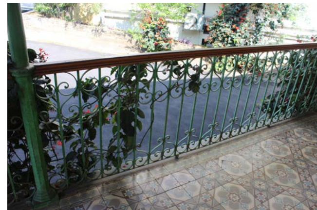
Figura 12. Gradis de ferro da varanda da entrada principal do Pavilhão 4. Fonte: Paulo Fraga Silveira, 2018.
