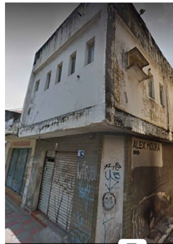
IMAGEM FRONTAL EDIFICAÇÃO RDB - 199 (AGO. DE 2015)
