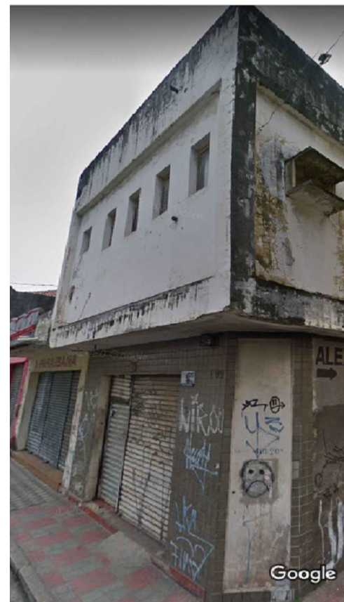
IMAGEM FRONTAL EDIFICAÇÃO RDB - 199 (AGO. DE 2019)
