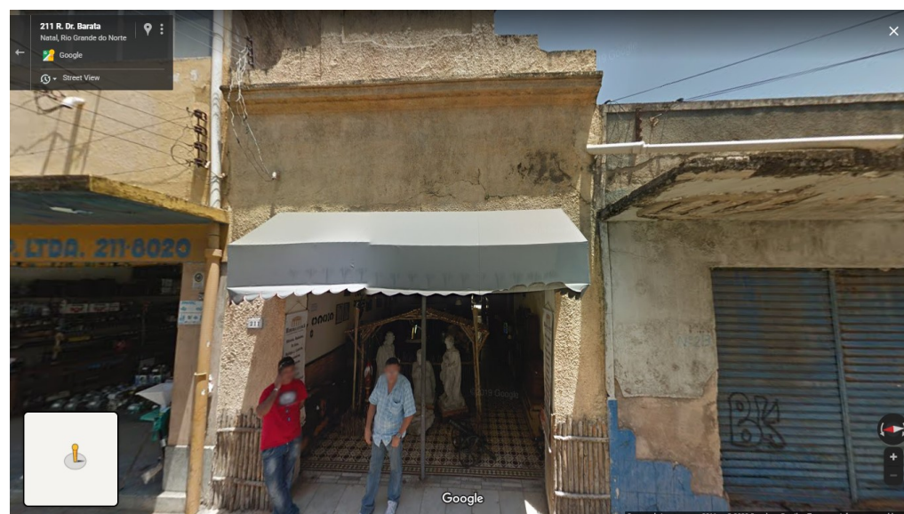
IMAGEM FRONTAL EDIFICAÇÃO RDB-211 (NOV. DE 2011)
