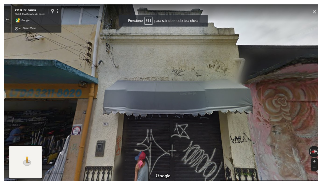
IMAGEM FRONTAL EDIFICAÇÃO RDB-211 (AGO. DE 2019)
