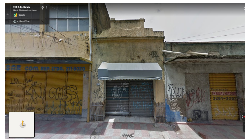
IMAGEM FRONTAL EDIFICAÇÃO RDB-211 (DEZ. DE 2014)
