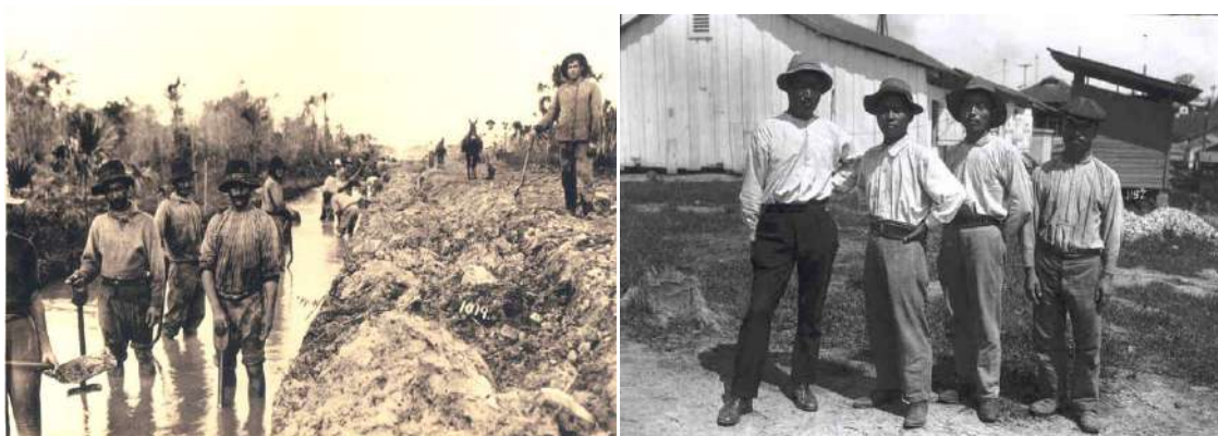
Figura 62. Operários na abertura de vala da ferrovia e trabalhadores orientais. Acervo Dana Merrill.
