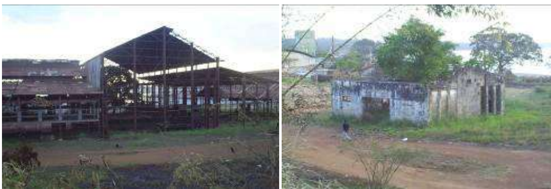
Figura 23. Pátio da ferrovia em 2007. Ruínas da Usina de Força. Fotos Cristina e Pedro Barreiros.
