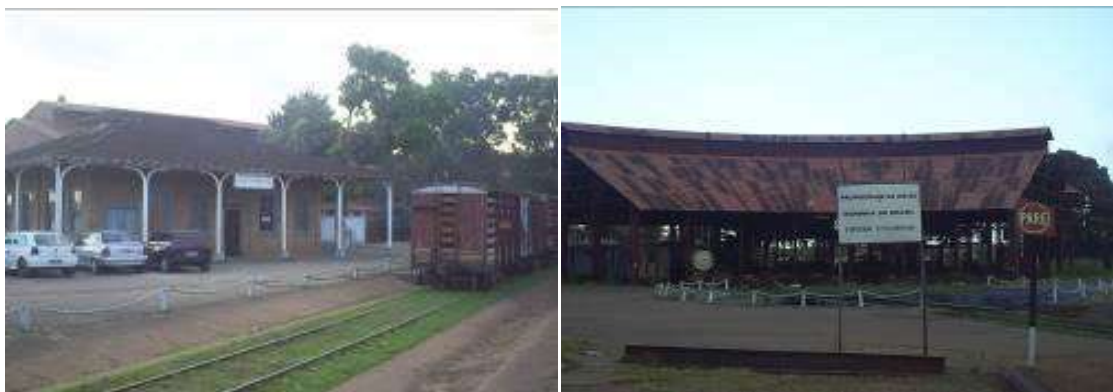
Figura 22. Pátio da ferrovia em 2007. Fotos Cristina e Pedro Barreiros.
