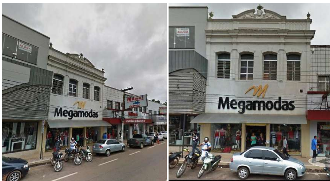
Figura 19. Prédio da Cooperativa dos Seringalistas de Rondônia. Fonte: Google Street View, acesso em 15/03/2015.
