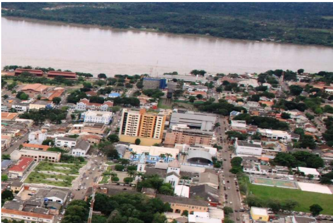
Figura 139. Caiari vista aérea atual. Fonte: consórcio das Usinas do Madeira.
