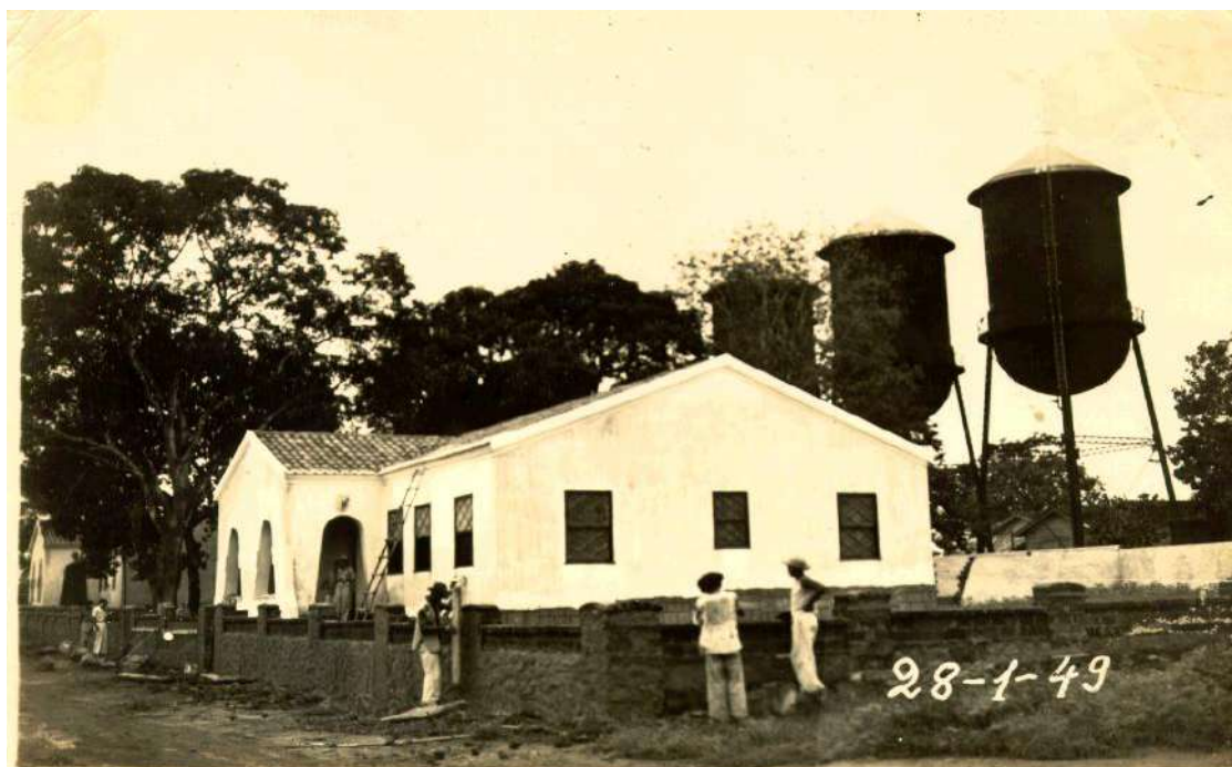
Figura 131. Residências sendo construídas no Caiari. Ao fundo as caixas d'água de abastecimento da cidade de então. Acervo arquiteta Teresa Nicácio.
