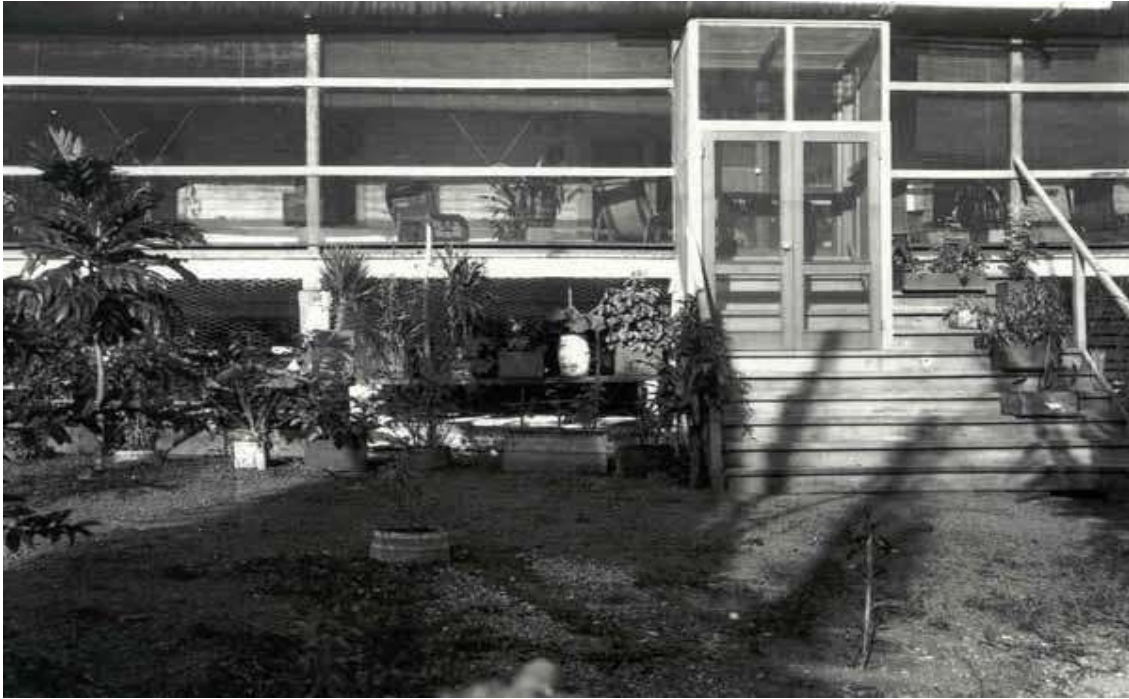
Figura 68. Vista externa de residência em Porto Velho. A varanda é protegida com tela fina, metálica, contra os mosquitos. Cerca de 1909-1910. Arquivo Dana Merrill.
