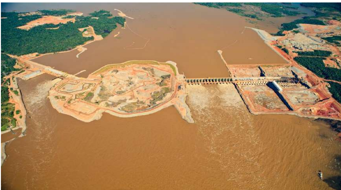
Figura 49. Usina de Santo Antonio, 2012. Fonte Consórcio das Usinas do Madeira.
